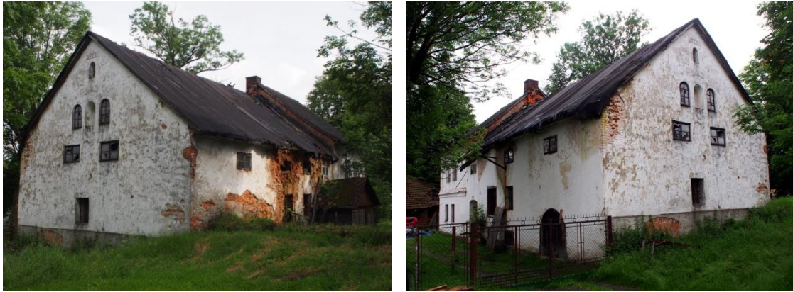
Widok młyna i budynku mieszkalnego, Rybarzowice
