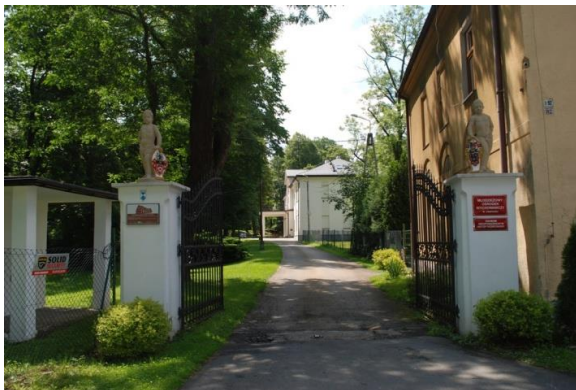
Murowane postumenty flankujące wjazd
