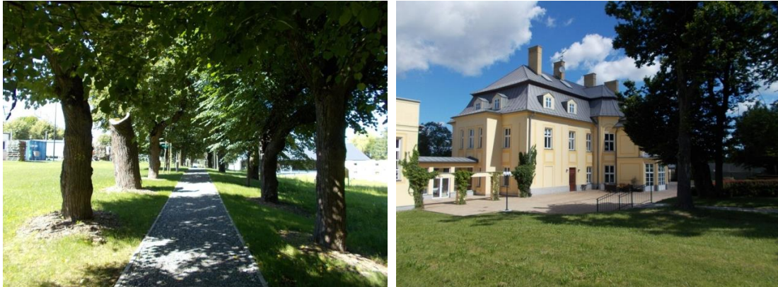
Zrewitalizowana aleja lip kandelabrowych na północ od pałacu oraz widok pałacu od strony ogrodu
