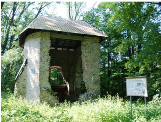
Ruiny kaplicy zamkowej
