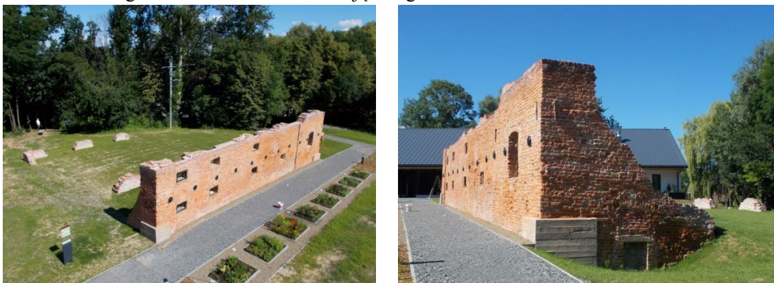
Zachowany fragment dworu, widok z wieży widokowej oraz od strony północnej
