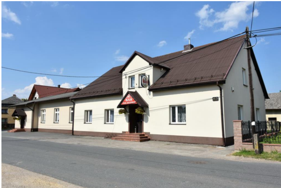
Ilustracja 23: Miedzna, budynek dawnej gospody przy ul. Wiejskiej 80
