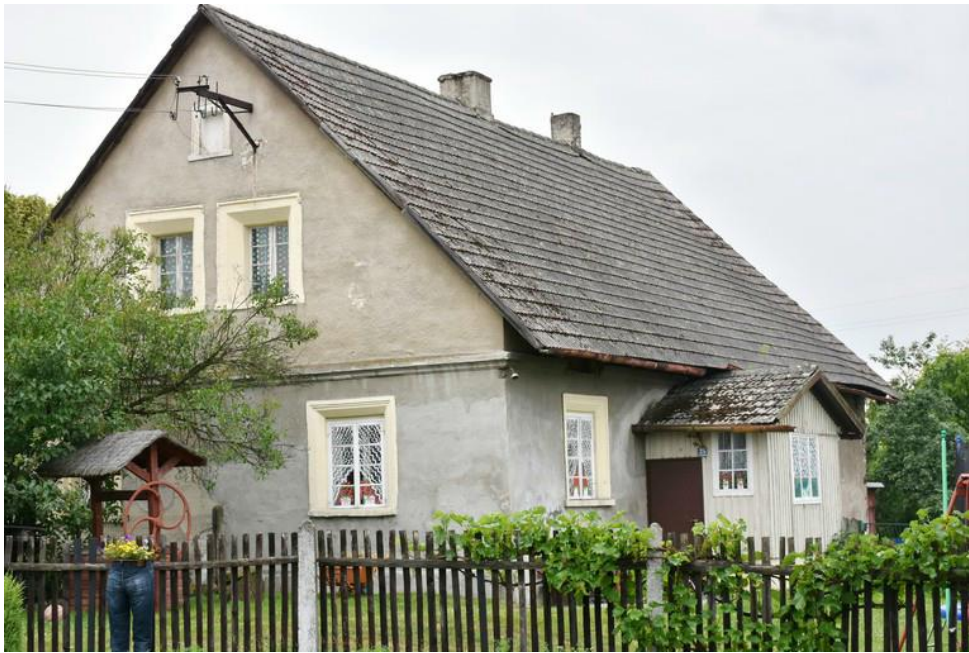
Ilustracja 17: Gilowice, ul. Korfantego 25, Budynek mieszkalny
