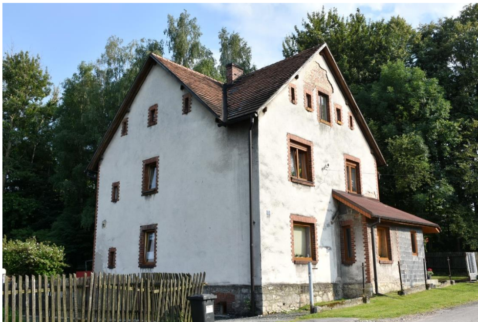
Ilustracja 24: Dawny budynek urzędu celnego w Górze przy ulicy Nad Wisłą 23
