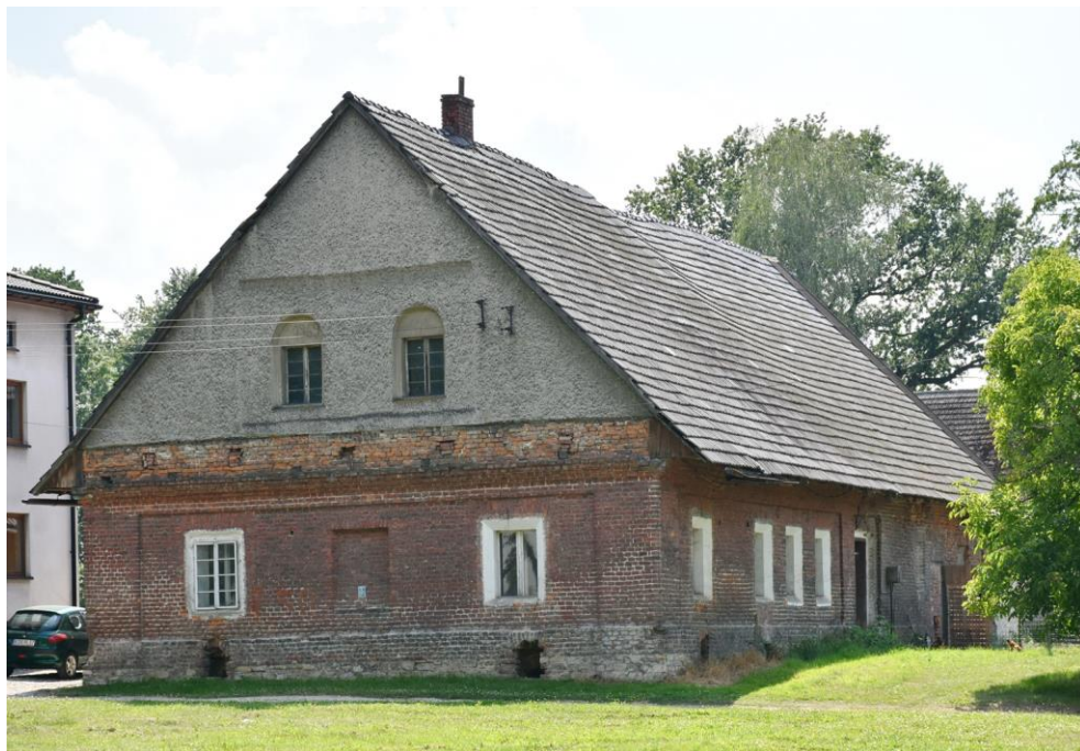
Ilustracja 15: Miedzna ul Wiejska 31 Budynek mieszkalny
