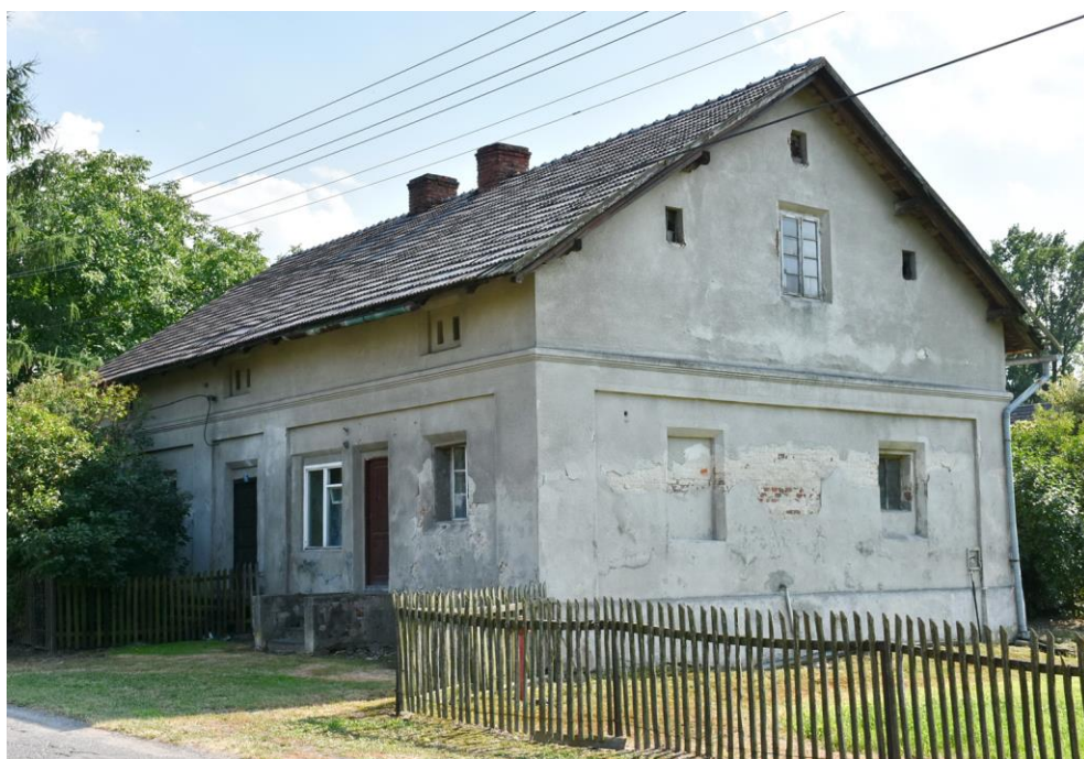
Ilustracja 16: Miedzna ul Wiejska 65 Budynek mieszkalny
