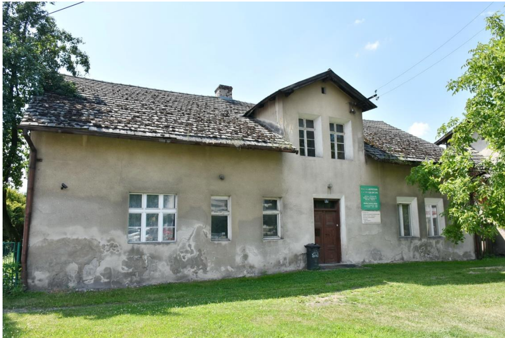
Ilustracja 21: Miedzna, ul. Wiejska 1 ceglany budynek z nadbudowaną w osi facjatą
