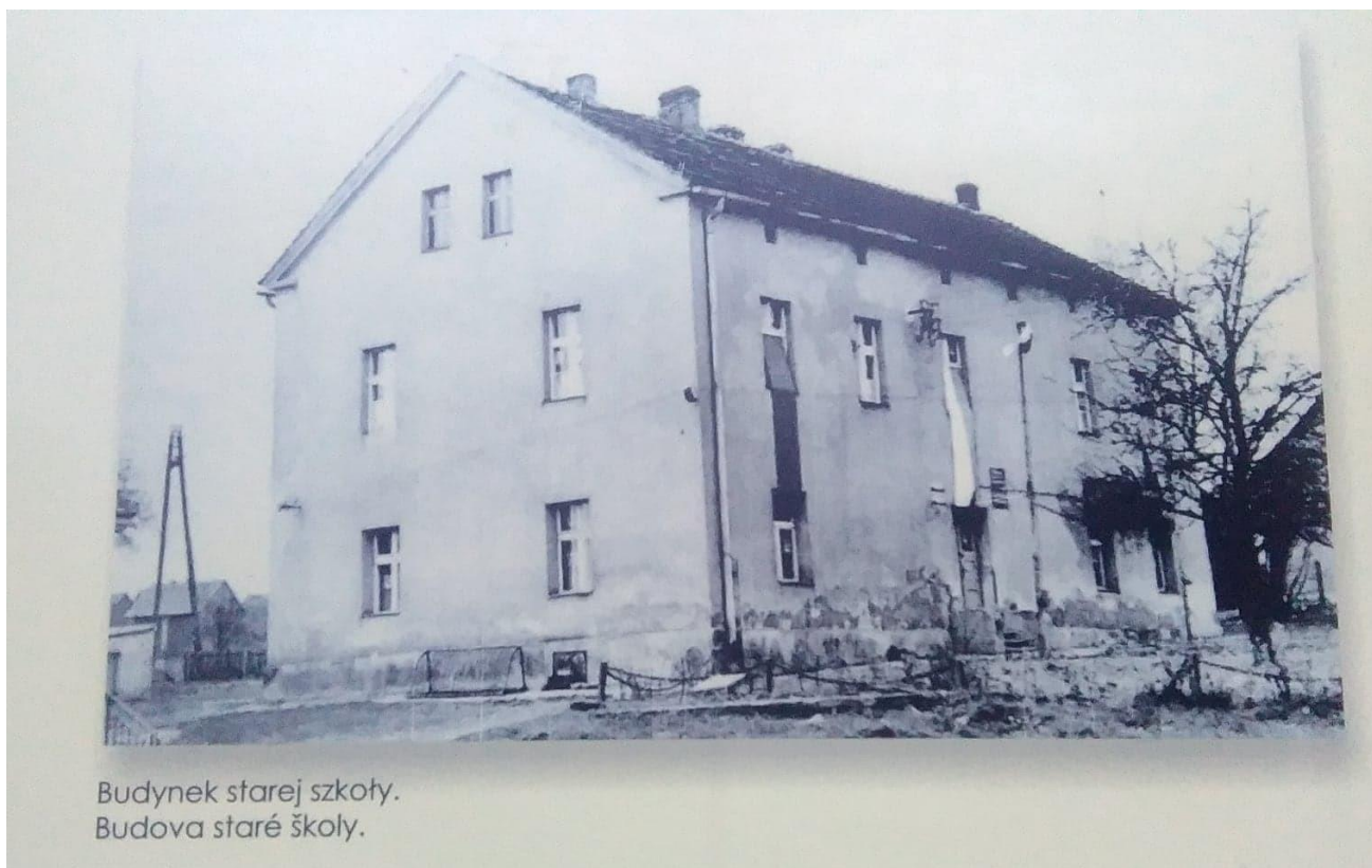
Ilustracja 21: Archiwalne zdjęcie szkoły w Skrzyszowie wybudowanej w 1830r.a rozbudowanej o piętro w 1863r.
