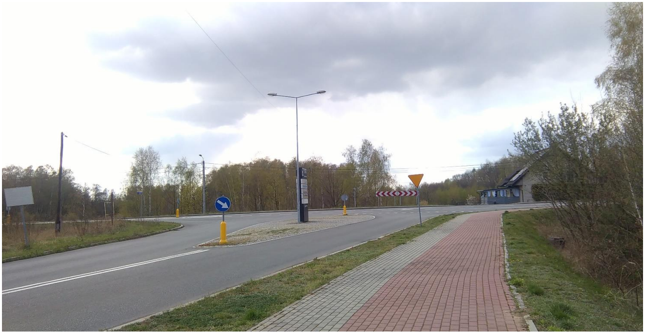
Ilustracja 74: Skrzyszów – skrzyżowanie ul. 1 Maja i ul. Jana Pawła II zdjęcie z 2019r.
