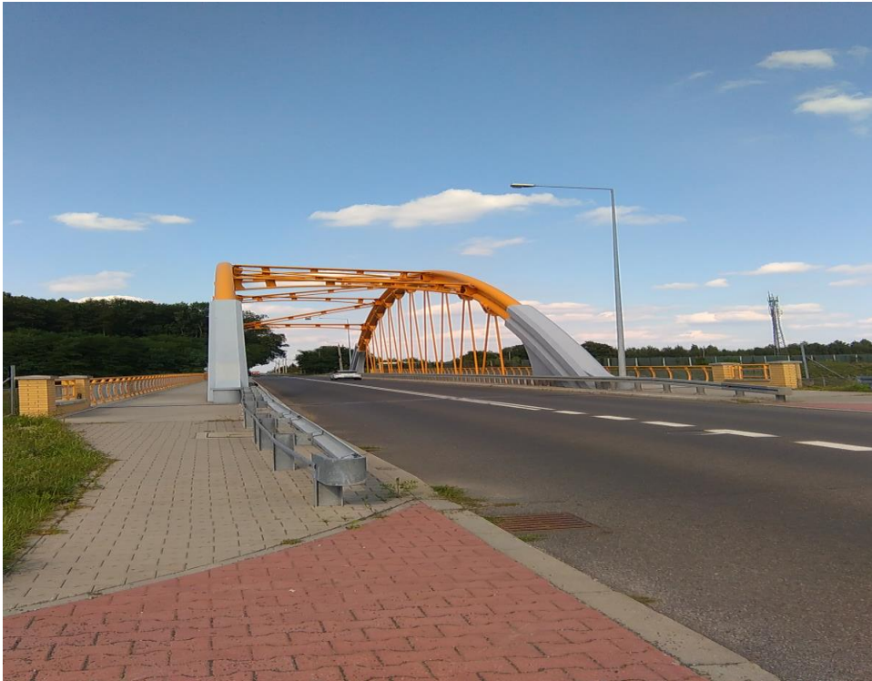
Ilustracja 80: Skrzyszów - ul. 1 Maja widok na most nad autostradą A1 zdjęcie z 2019r.
