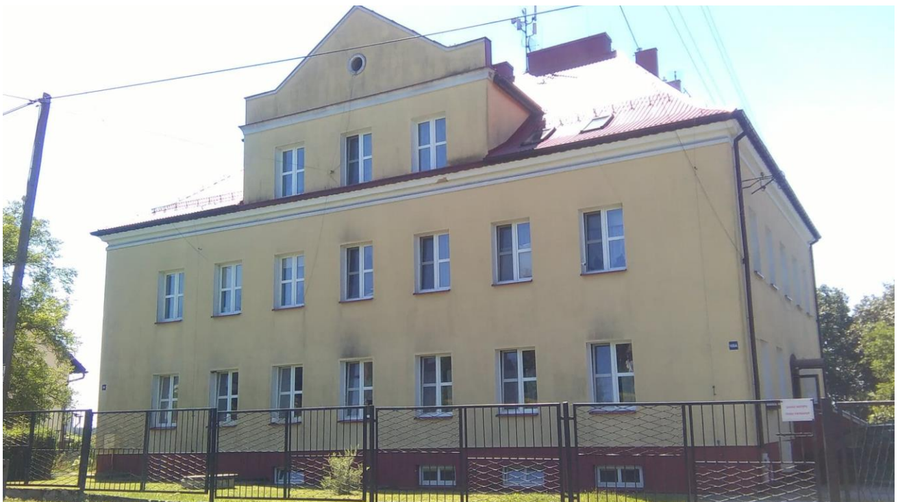
Ilustracja 61: Budynek Wojsk Ochrony Pogranicza. Obecnie budynek wielorodzinny. Skrzeńsko, ul. Piotrowicka zdjęcie z 2019r.
