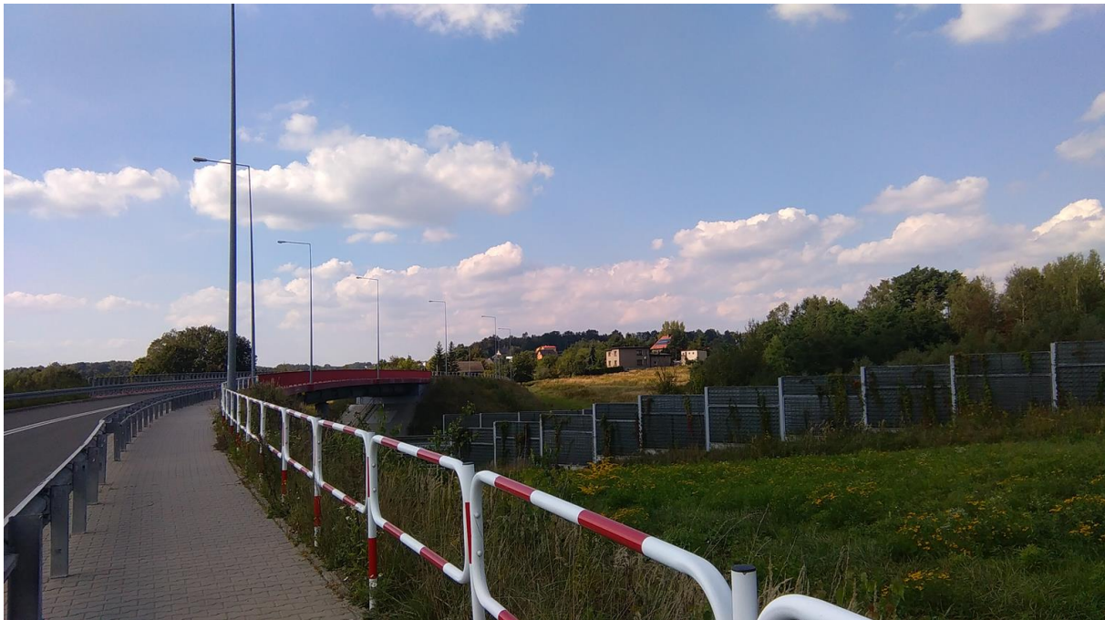
Ilustracja 41: Krostoszowice widok na autostradę A1 rok 2019
