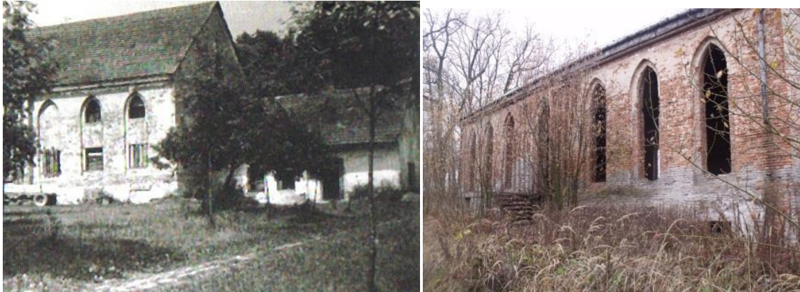
Kłobukowice, spichlerz w zespole dworskim, stan z 1978 r. po prawej stan 2019
