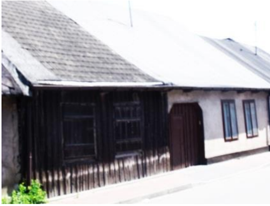
Mstów, zmodernizowana cz. domu przy ul. Kilińskiego 14
