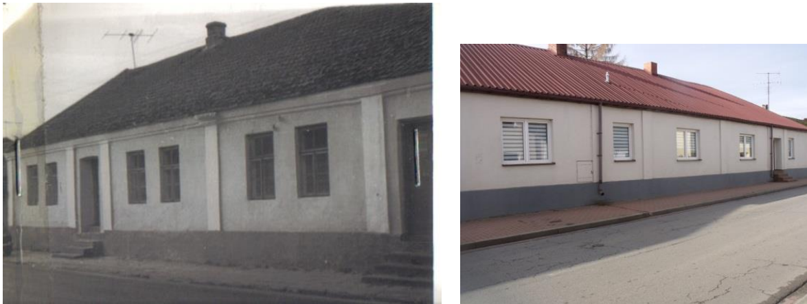
Mstów, dom, Pl. Mickiewicza 16, przed remontem (1990 r.) i po remoncie 2019
