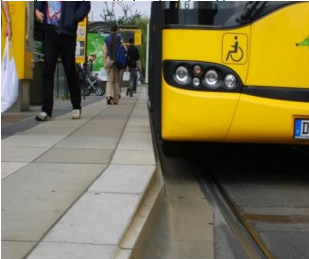
Rys. 9.11 Zalecane ukształtowanie podniesionej krawędzi peronowej
