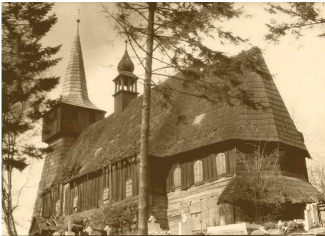
Fotografia 15: Widok na drewniany kościół Nawiedzenia NMP-strona południowo-wschodnia
