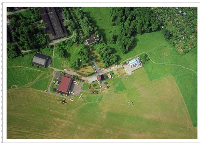
Kompleks budynków lotniska
