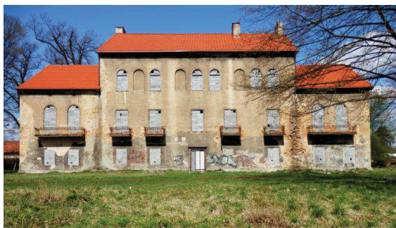
PAŁAC W BARANOWICACH. [źródło: Wikipedia]
