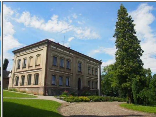
Szkoła i fragm. drogi w zespole kościoła ewangelicko-augsburskiego w Jaworzno
