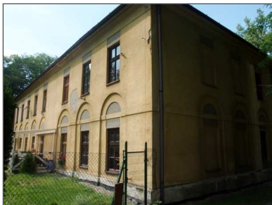
Budynek przybramny, widok od południa
