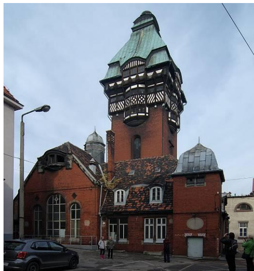
Wieża wodna i budynki pomocnicze w zespole szpitala spółki brackiej [źródło: www.fotopolska.eu]
