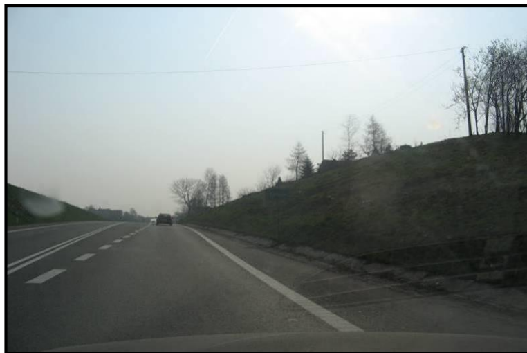
Fot. 1. Wykorzystanie ekranujących własności wykopu (droga krajowa nr 94 na odcinku Kraków – Tarnów)
