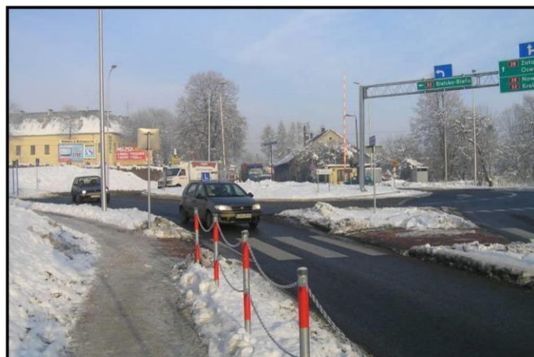
Fot. 7. Przykład ograniczenia prędkości i jednoczesnego utrzymania płynności ruchu poprzez zastosowanie ronda (droga krajowa nr 52 – Wadowice)
