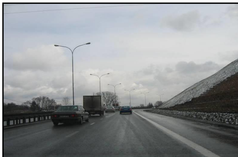
Fot. 9. Przykład wału ziemnego chroniącego zabudowę przed oddziaływaniem hałasu (odcinek drogi krajowej nr 94 Kraków – Tarnów)
