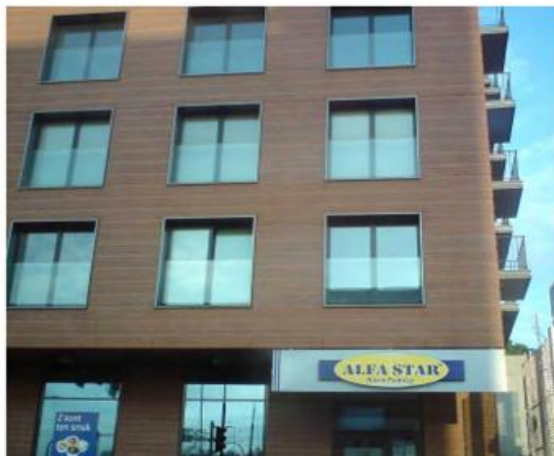
Rysunek 12-11 Ochrona mieszkań przed hałasem, za pomocą przezroczystych „ekranów” umieszczonych we wnęce okiennej (Kraków) (źródło: materiały własne).
