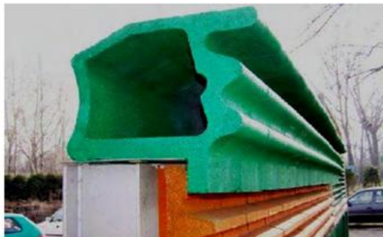
Rysunek 12-7 Dyfraktor zamontowany na krawędzi górnej ekranu akustycznego (źródło: www.techbud.com.pl )
