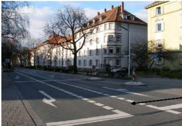
Rysunek 12-22 Wydzielony pas dla ruchu rowerów. Rower nie koliduje ze skręcającymi w prawo – Darmstadt (Niemcy) (źródło: materiały własne).
