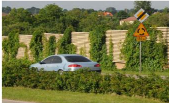
Rysunek 12-6 Ekran akustyczny w mieście porośnięty zielenią (źródło: www.techbud.com.pl )
