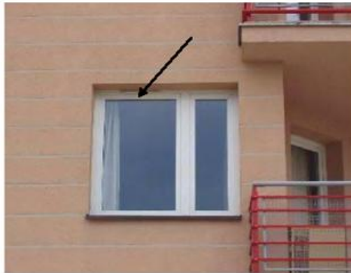
Rysunek 12-26 Okno dźwiękoszczelne z nawietrzakiem (źródło: materiały własne).
