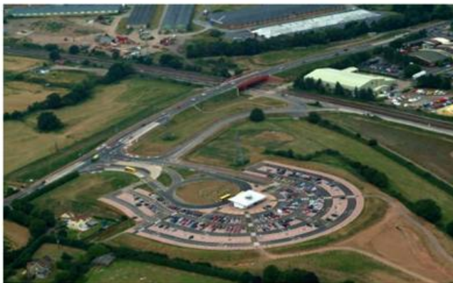
Rysunek 12-17 Parking P+R przy wjeździe do Taunton w hrabstwie Somerset (Anglia). Na zdjęciu widoczna pętla autobusowa zlokalizowana w obrębie parkingu (źródło: www.movingsomersetforward.co.uk )
