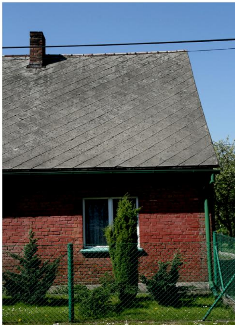
Rysunek 4 Dach budynku mieszkalnego pokryty płytami azbestowymi płaskimi Fotografia Agnieszka Chylak
