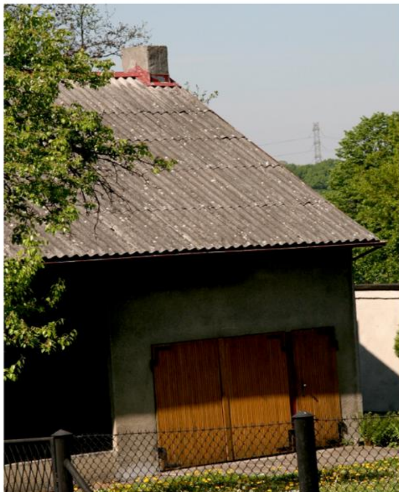
Rysunek 3 Dach pokryty płytami azbestowymi falistymi Fotografia Agnieszka Chyłak
