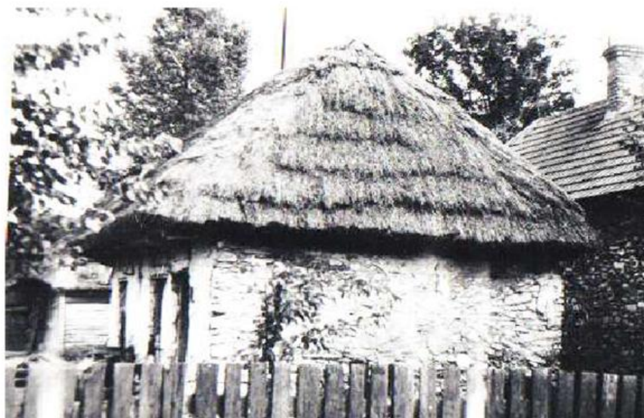
Jaźwiny , nieistniejąca murowana obora w zagrodzie nr 26, foto 1982, AWKZ
