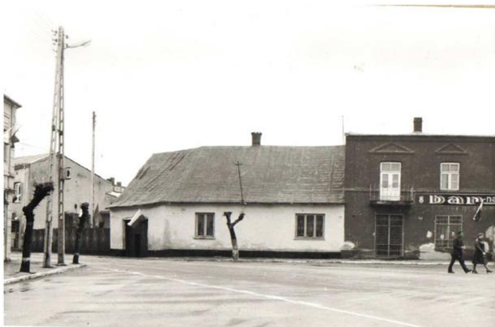
Mstów, nieistniejący budynek narożny, foto z 1979 r. AWKZ w Częstochowie
