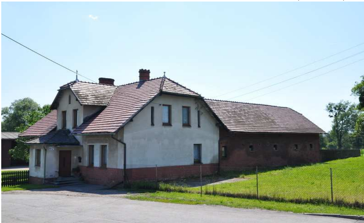
Ilustracja 15: Zabudowa przy ul. Świerklańskiej 67.
