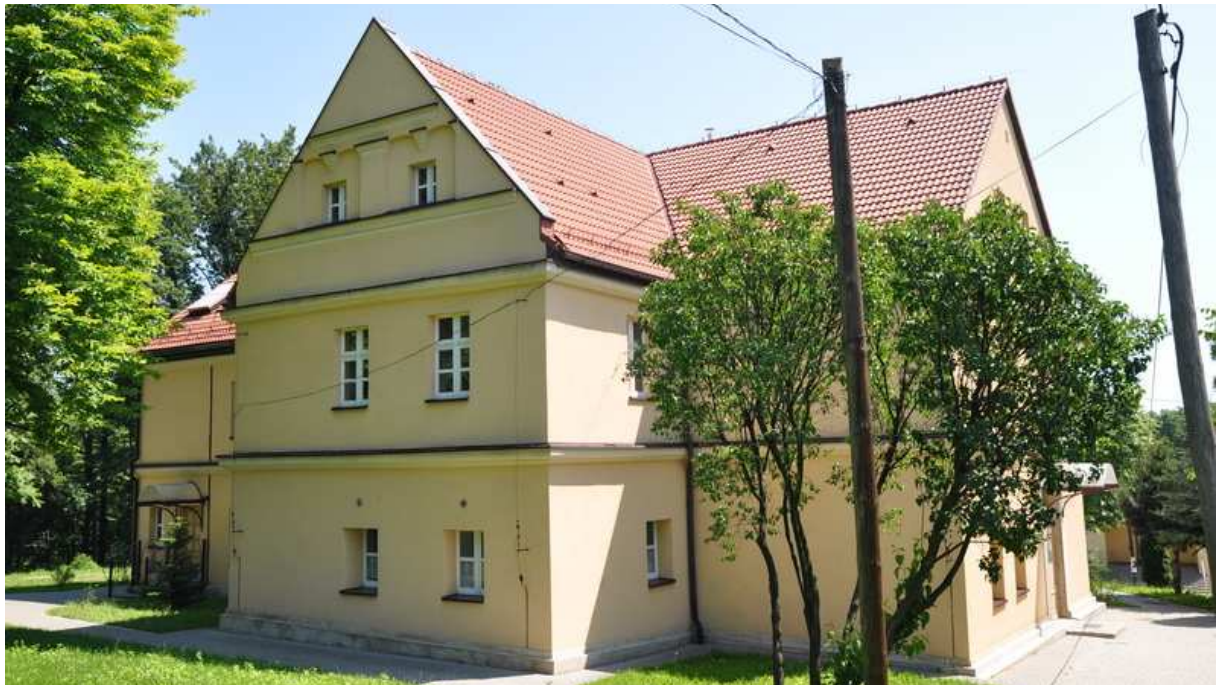
Ilustracja 9: Budynek przy ul. Klubowej 2.
