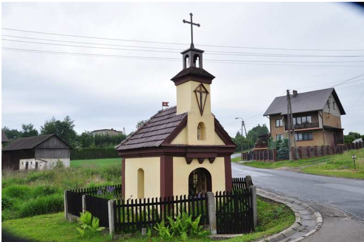
Ilustracja 16: Kaplica architektoniczna przy ul. Dąbrowskiego.
