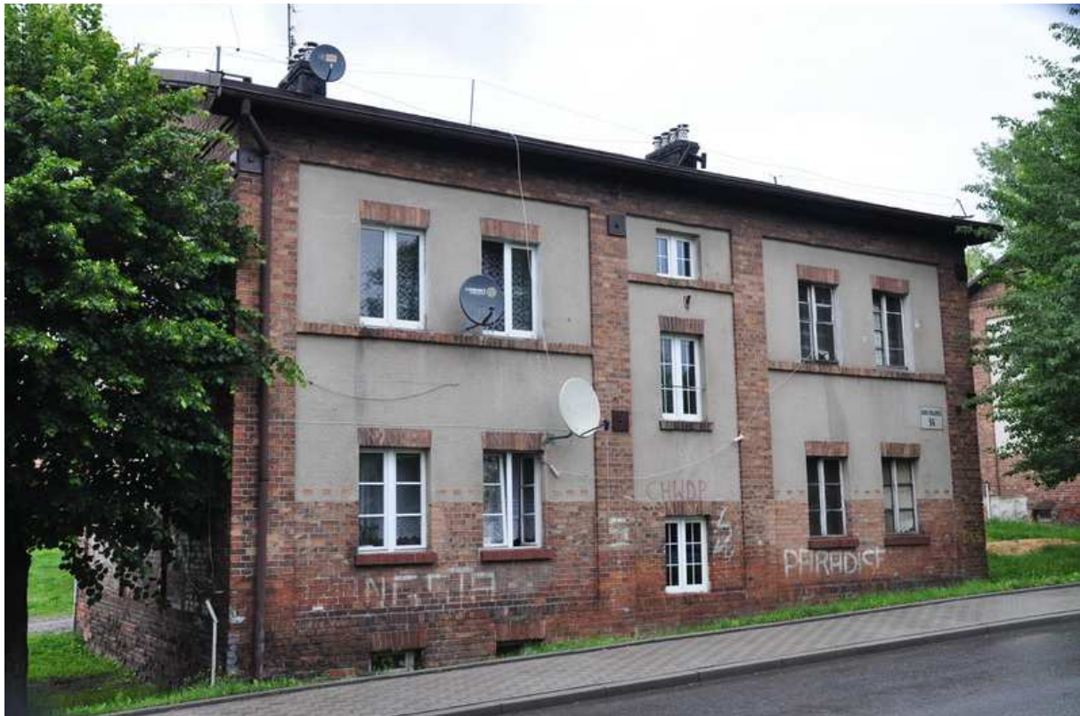
Ilustracja 8: Budynek mieszkalny przy ul. Armii Krajowej 94.
