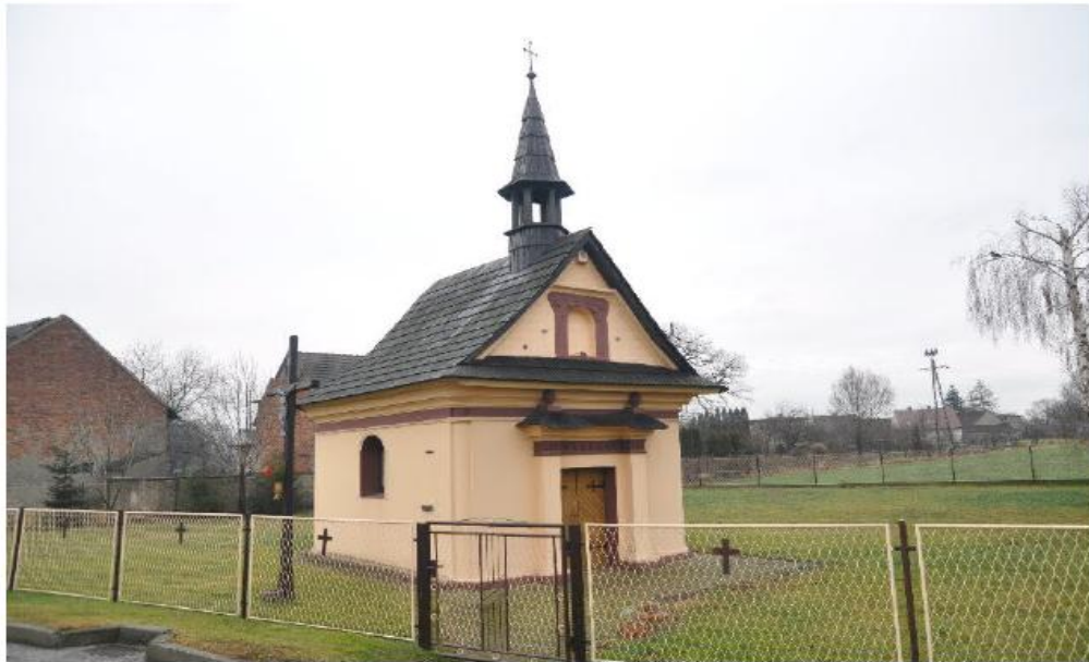
Ilustracja 18: Olza, ul. Wiejska 16 - kaplica architektoniczna z około 1800 roku.
