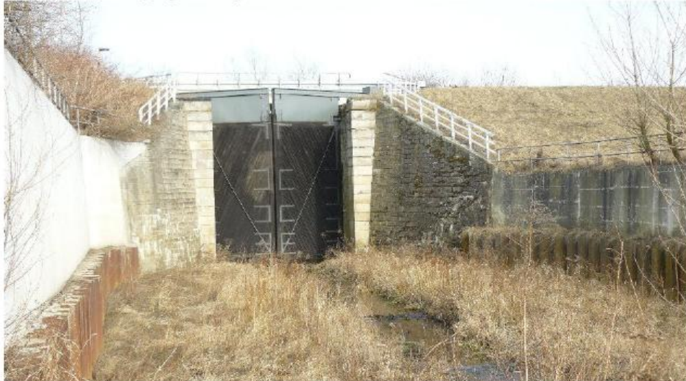
Ilustracja 32: Olza - przepust wałowy z drewnianymi wrotami.
