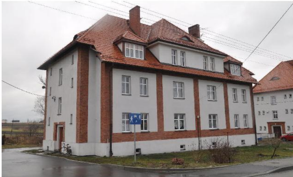
Ilustracja 19: Kolonia Fryderyk, ul. Leśna 1 - budynek wchodzący w skład kolonii robotniczej przy kopalni.
