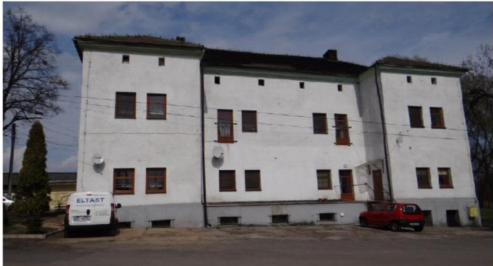
Ilustracja 25: Gorzyczki, ul. Wiejska 6 - dom inspektora.
