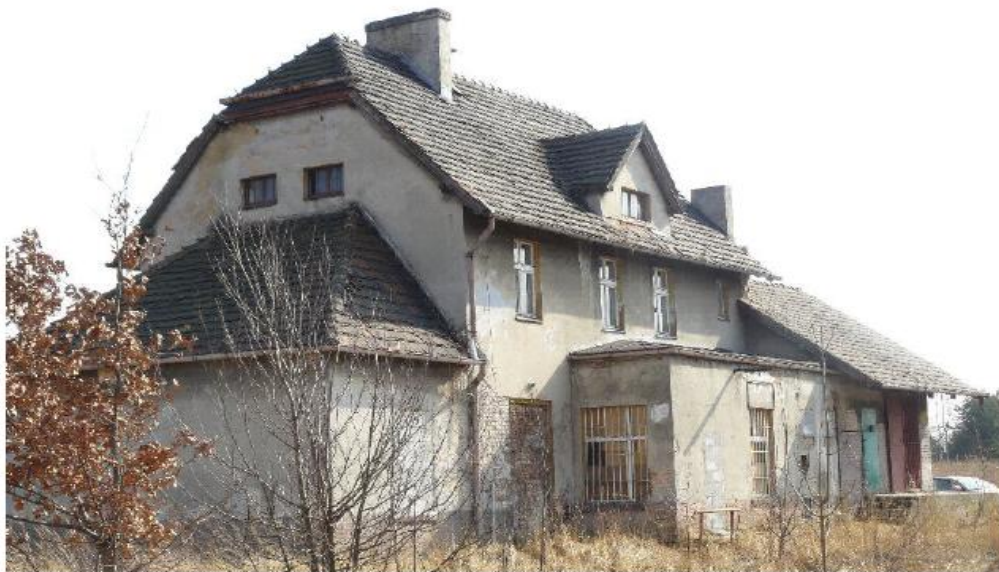
Ilustracja 14: Turza Śląska - budynek dworca kolejowego.
