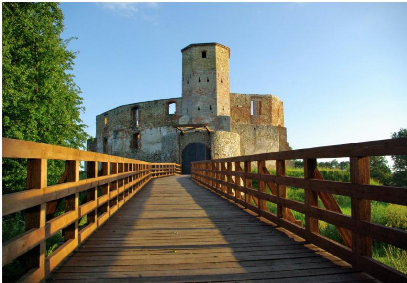
2.4. Zamek książąt śląskich, w latach 1443-1790 biskupów krakowskich – książąt siewierskich (Nr w rej. A/777/67) Po remoncie. Widoczne: kładka dla pieszych i most zwodzony.
