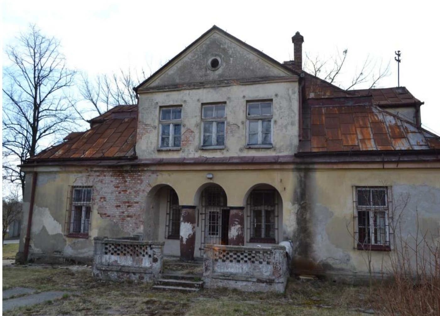
3.22 Zespół budynków Szpitala Gruźliczego w Siewierzu przy ul. Oleśnickiego 21. Willa.
