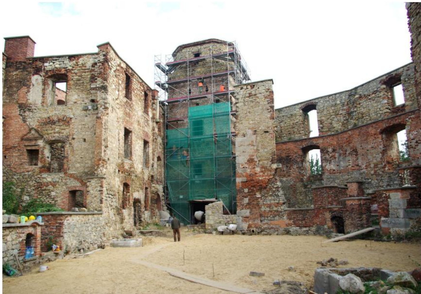
2.4. Zamek książąt śląskich, w latach 1443-1790 biskupów krakowskich – książąt siewierskich (Nr w rej. A/777/67). - w trakcie prac rekonstrukcyjnych murów i brukowania dziedzińca (11.09.2008 r.)
