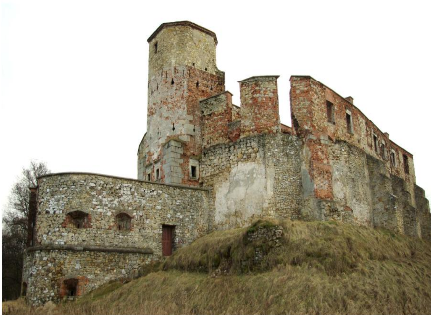
2.4. Zamek książąt śląskich, w latach 1443-1790 biskupów krakowskich – książąt siewierskich (Nr w rej. A/777/67). - przed rekonstrukcją i naprawą murów (luty 2008 r.)
