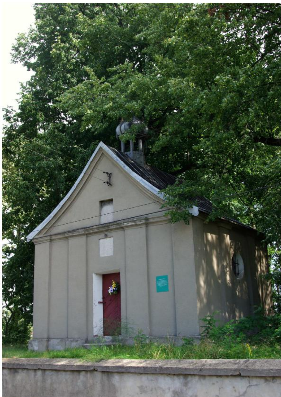
2.10. Kaplica Zalassowskich w Żeliszewicach (Nr w rej. A/801/67).
