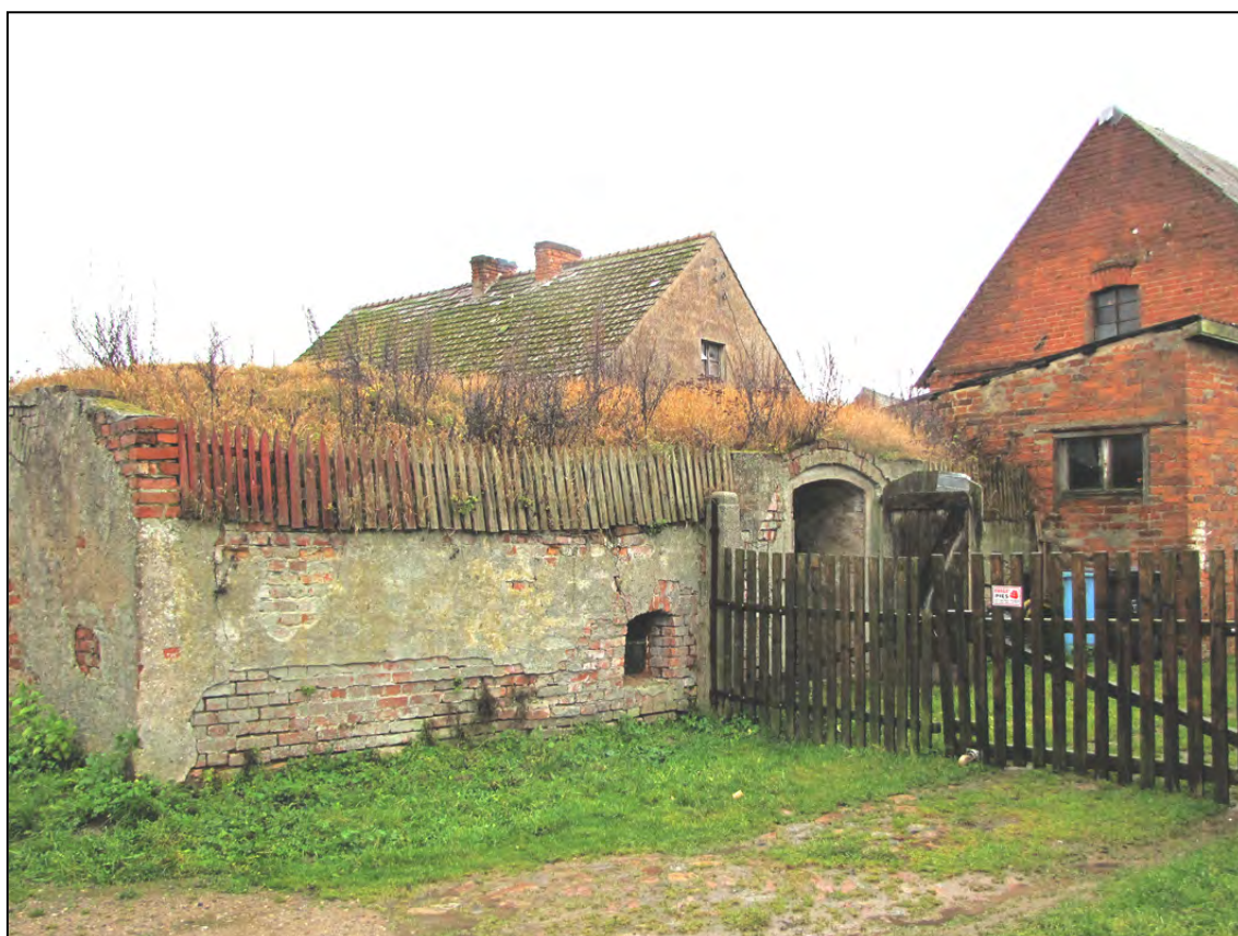
Sosnowo 21. Murowana piwnica wolnostojąca.
