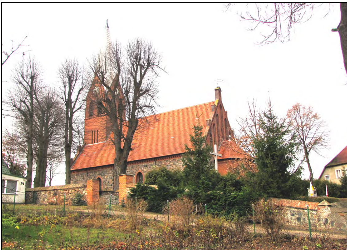
Swobnica. Kościół pw. św. Kazimierza Królewicza; widok od północnego zachodu
