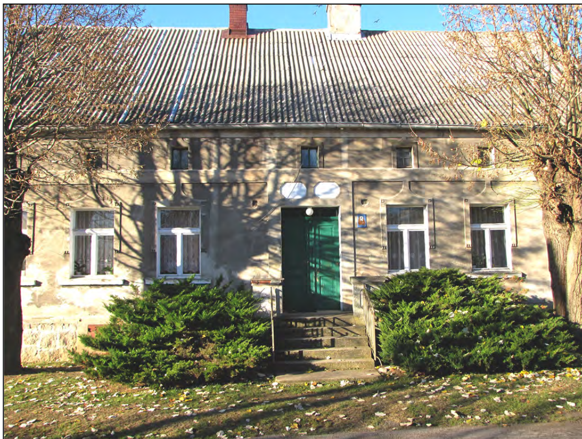
Lubanowo 8. Budynek mieszkalny (chałupa).
