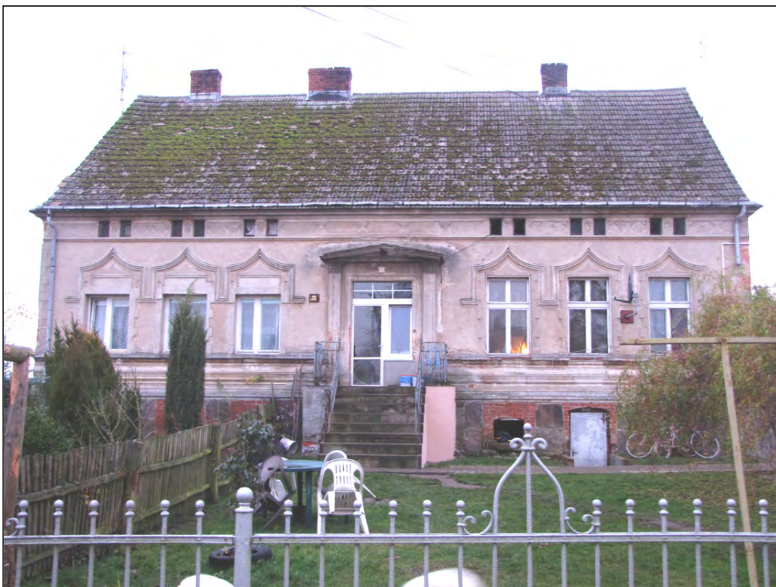
Górnówo 17. Budynek mieszkalny.
