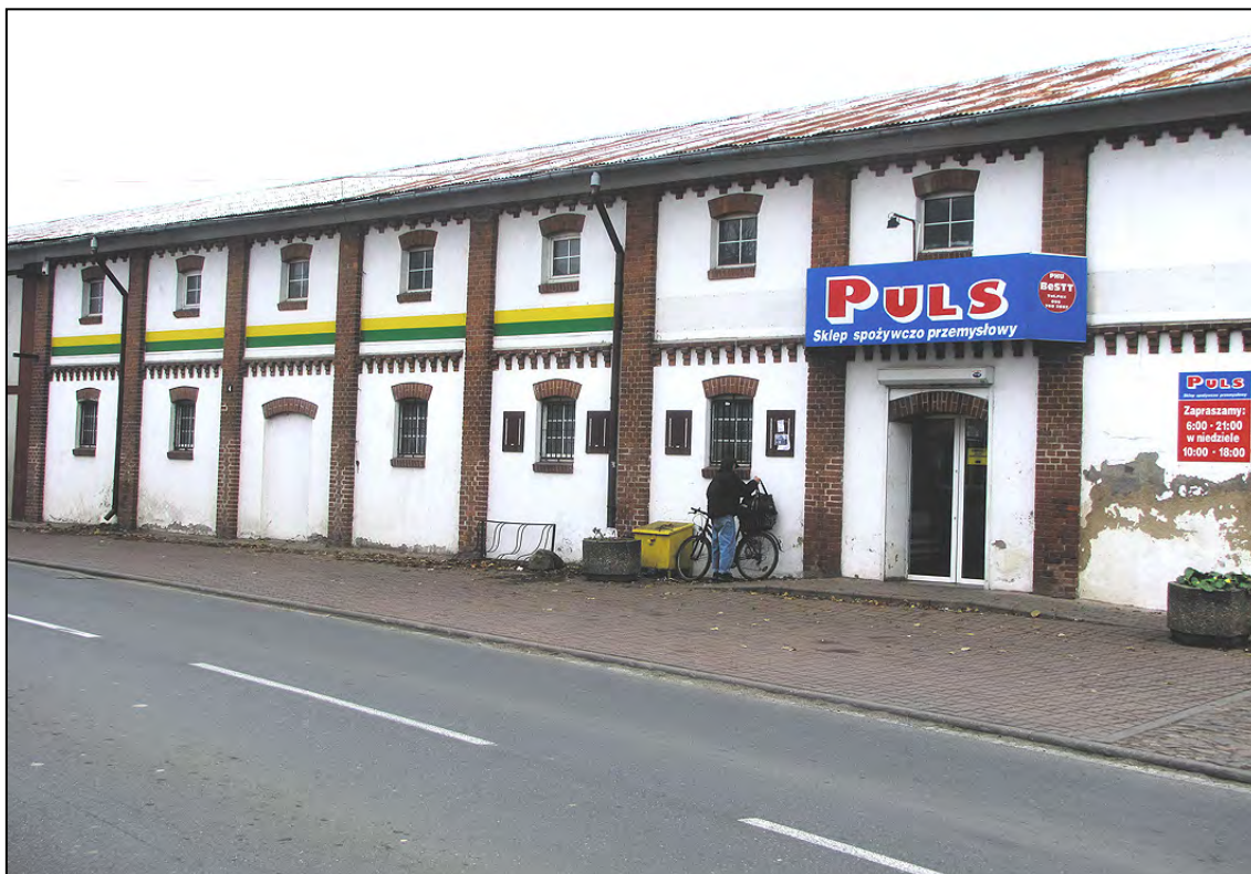
Banie. Ul. Targowa 4; dawna mieszalnia pasz, obecnie pawilon handlowy.
