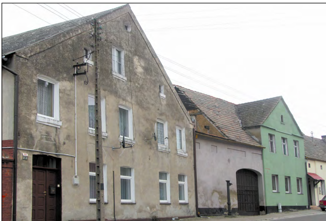
Banie. Ul. Chrobrego 21 i 23; budynki mieszkalne.
