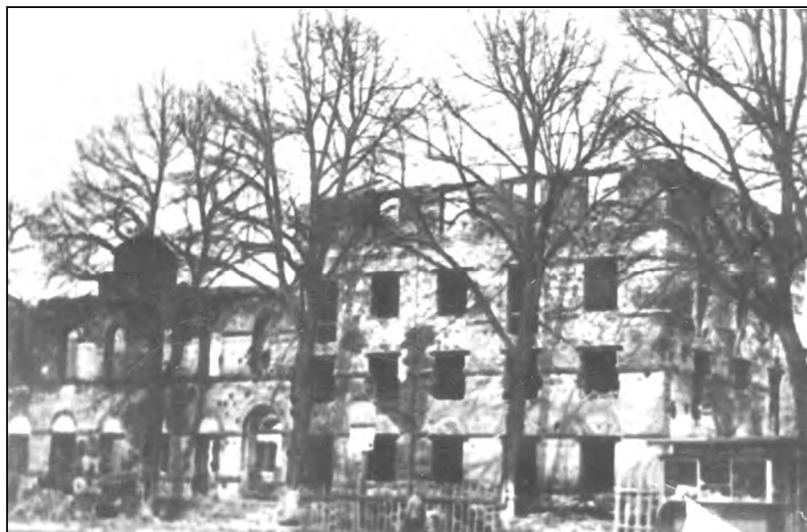
Banie. Ruiny Ratusza (elewacja północna). Stan ok. roku 1969
