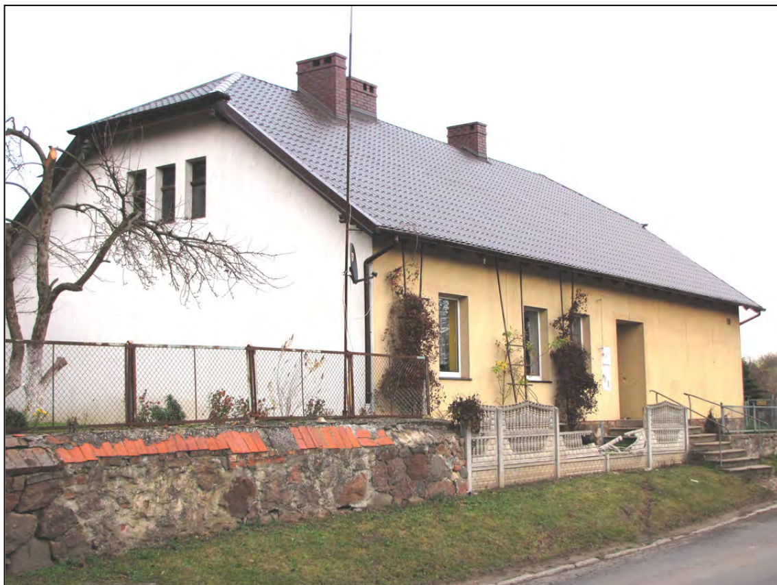
Rożnowo 20. Budynek mieszkalny (chałupa).
