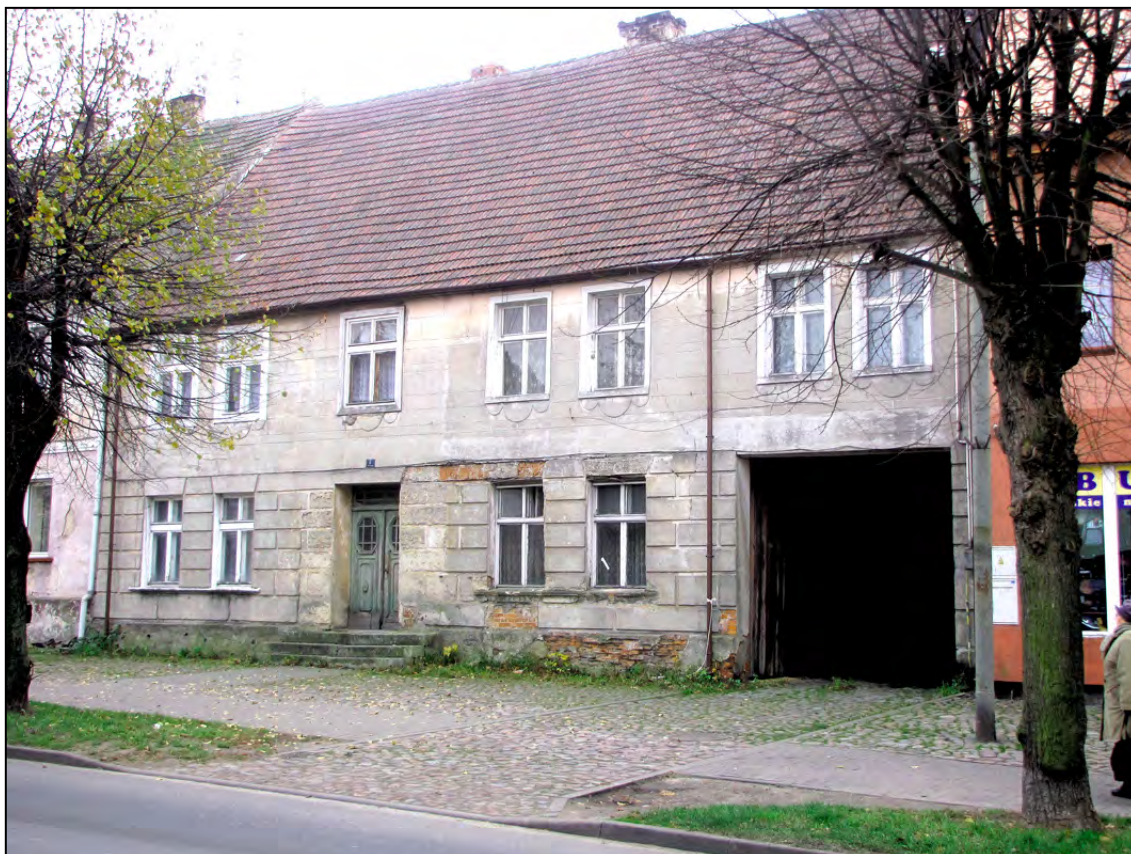
Banie. Ul. Grunwaldzka 8; budynek mieszkalny.
