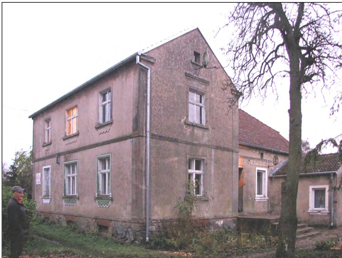
Górnowo 10. Budynek mieszkalny.
