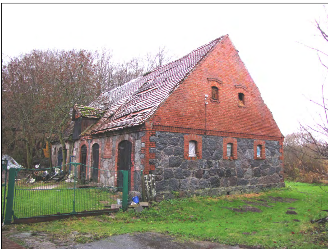
Piaseczno 67. Kamienno – ceglany budynek inwentarski.
