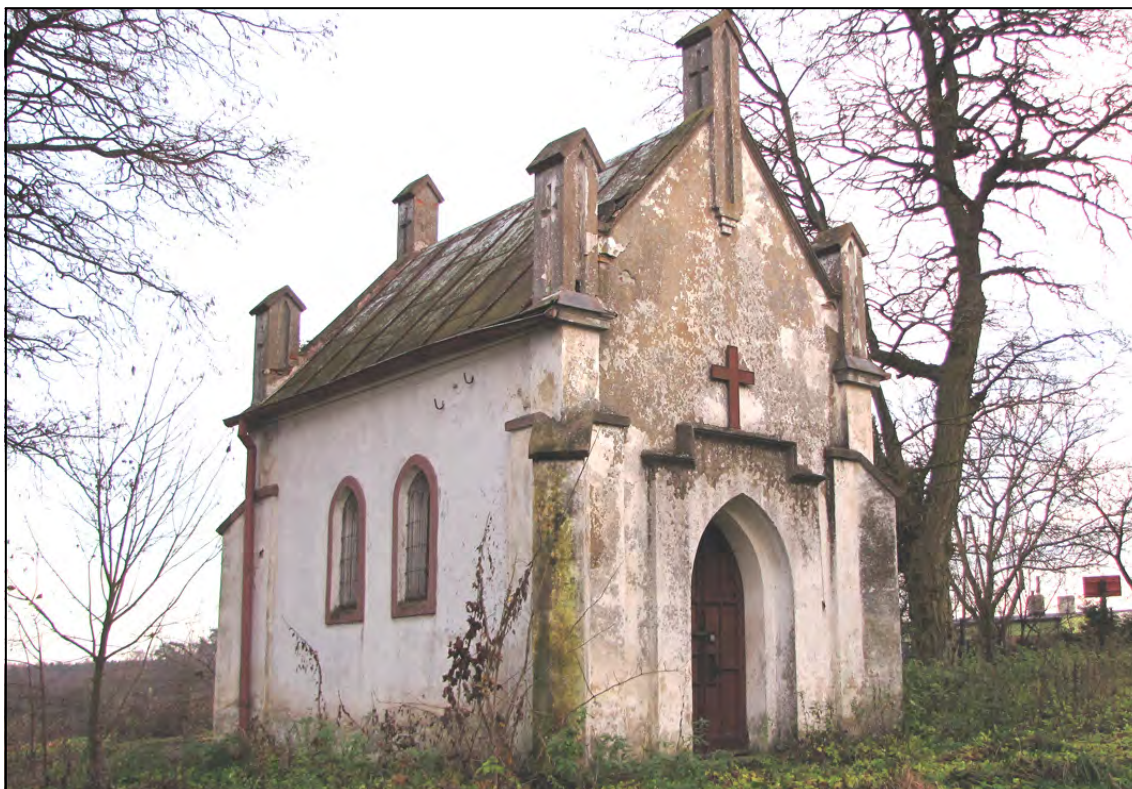
Rożnowo. Kaplica Cmentarna (pierwotnie grobowa); widok od północnego zachodu.
