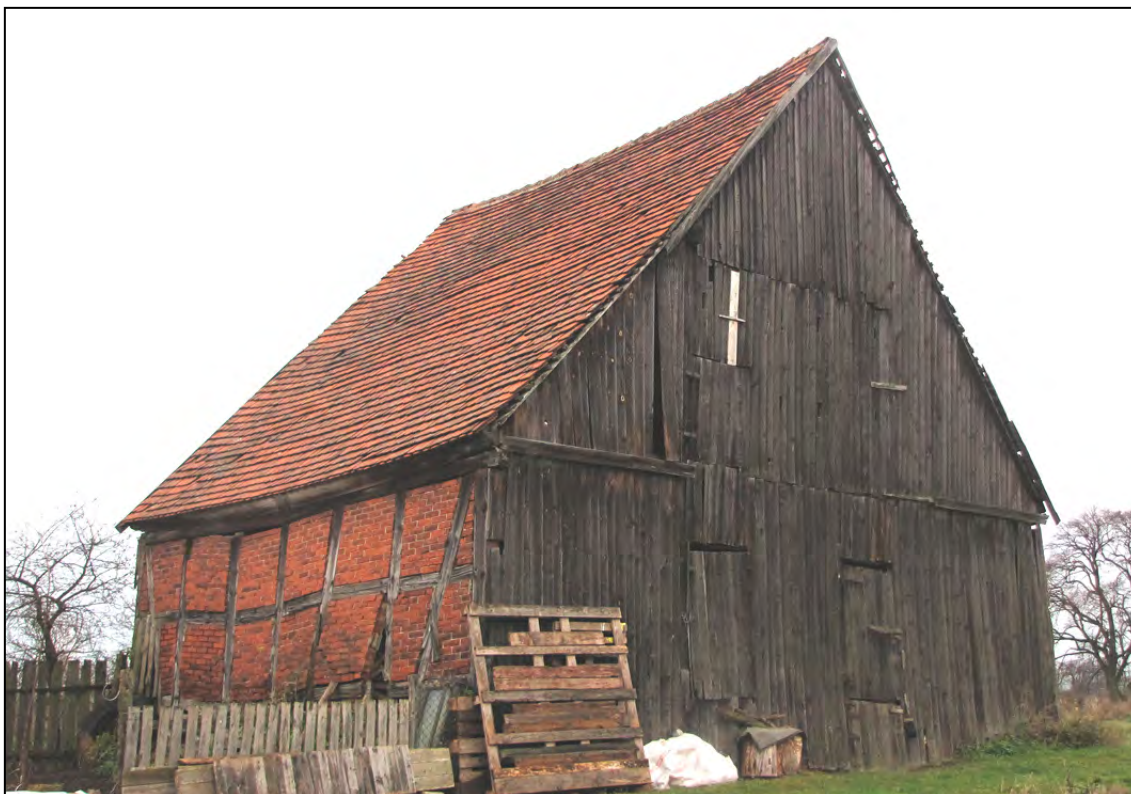
Piaseczno 109. Ryglowy (tzw. pruski mur) budynek gospodarczy.
