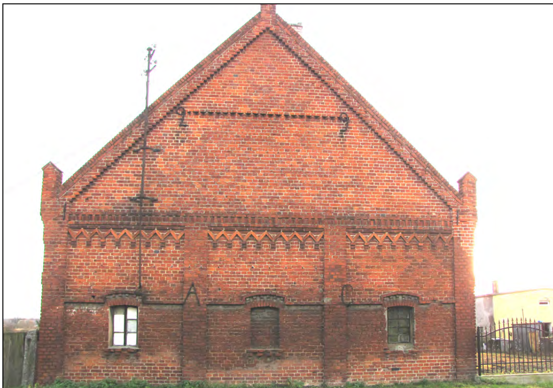
Swobnica 47. Budynek gospodarczy (ściana szczytowa).
