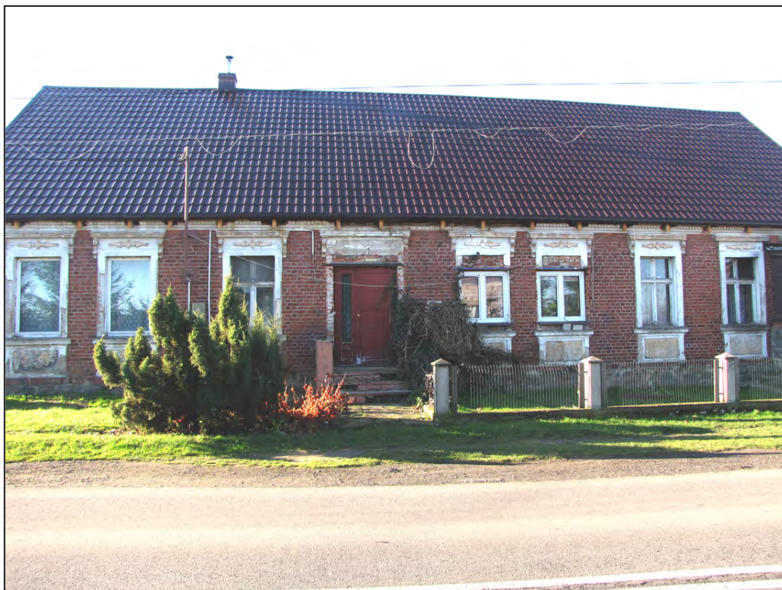
Lubanowo 26. Budynek mieszkalny (chałupa).
