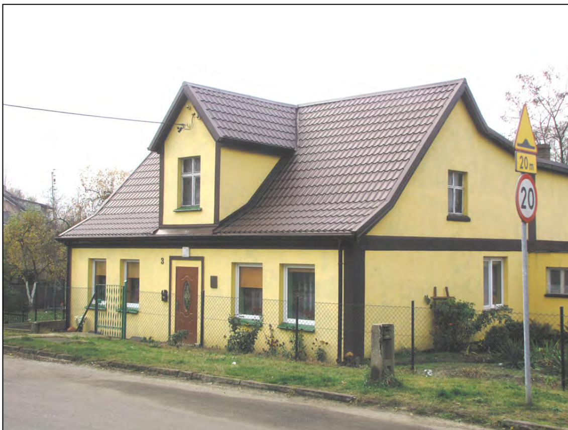
Banie. Ul. Ogrodowa 3; budynek mieszkalny.
