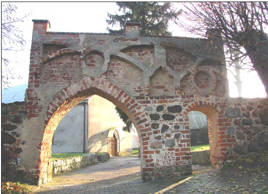
Baniewice. Północna bramka w murze cmentarza przykościelnego.
