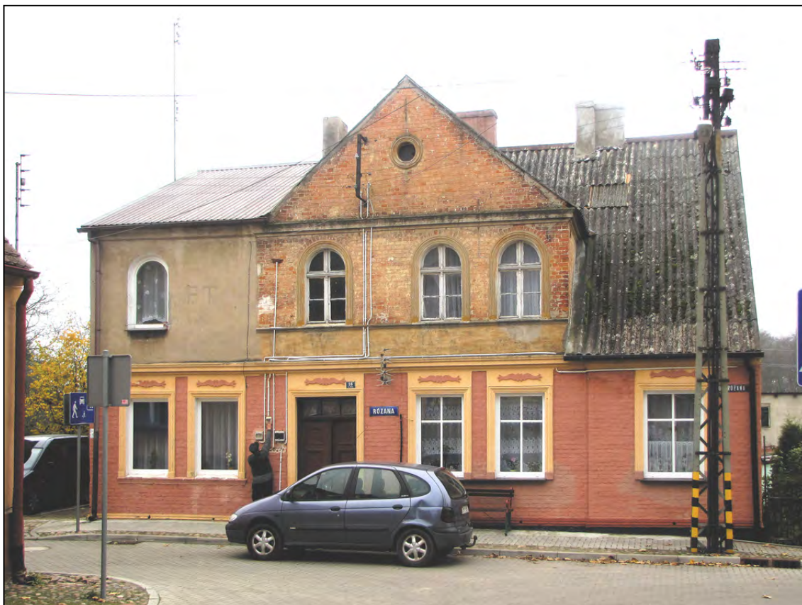
Banie. Ul. Różana 16; budynek mieszkalny.
