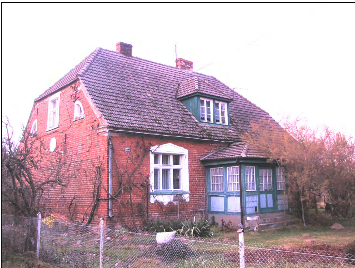
Swobnica 128. Budynek mieszkalny.
