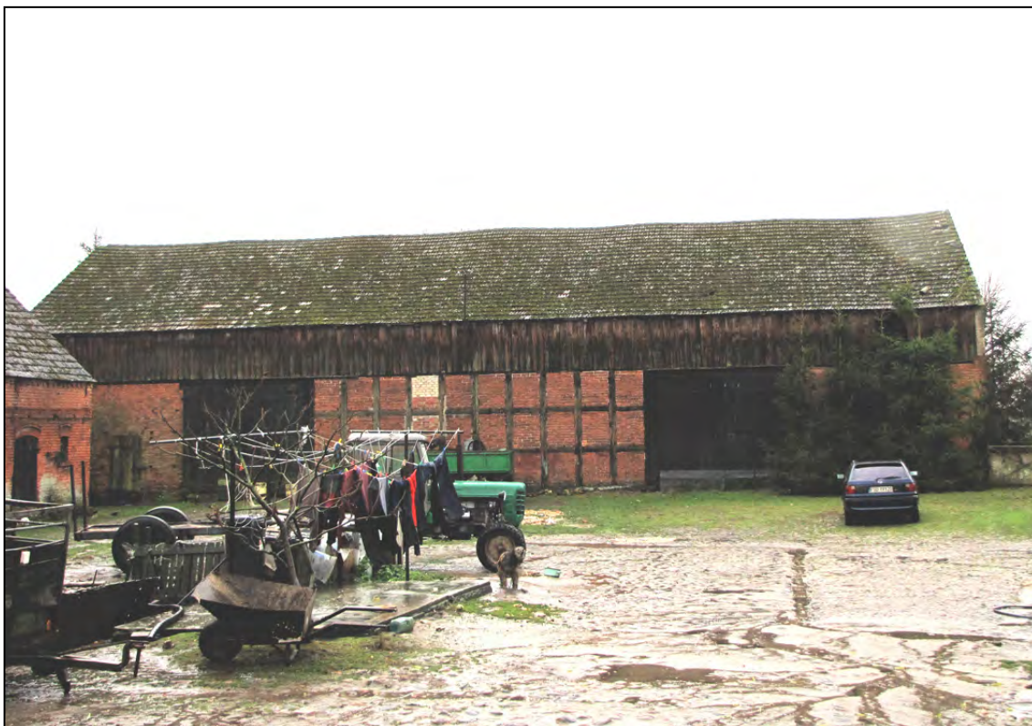
Piaseczno 32/33. Ryglowy (tzw. pruski mur) budynek gospodarczy.
