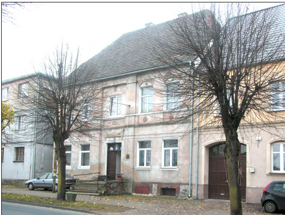
Banie. Ul. Grunwaldzka 14; budynek mieszkalny.
