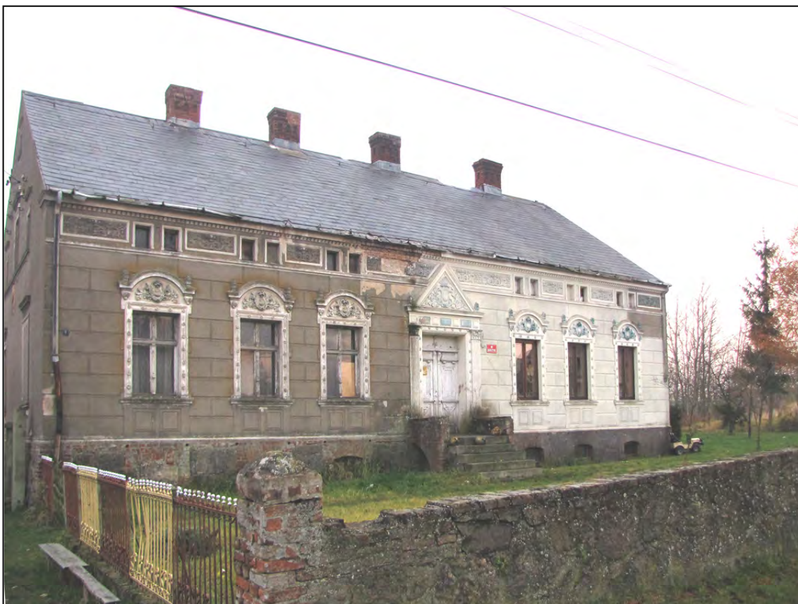
Górnowo 7/9. Budynek mieszkalny.
