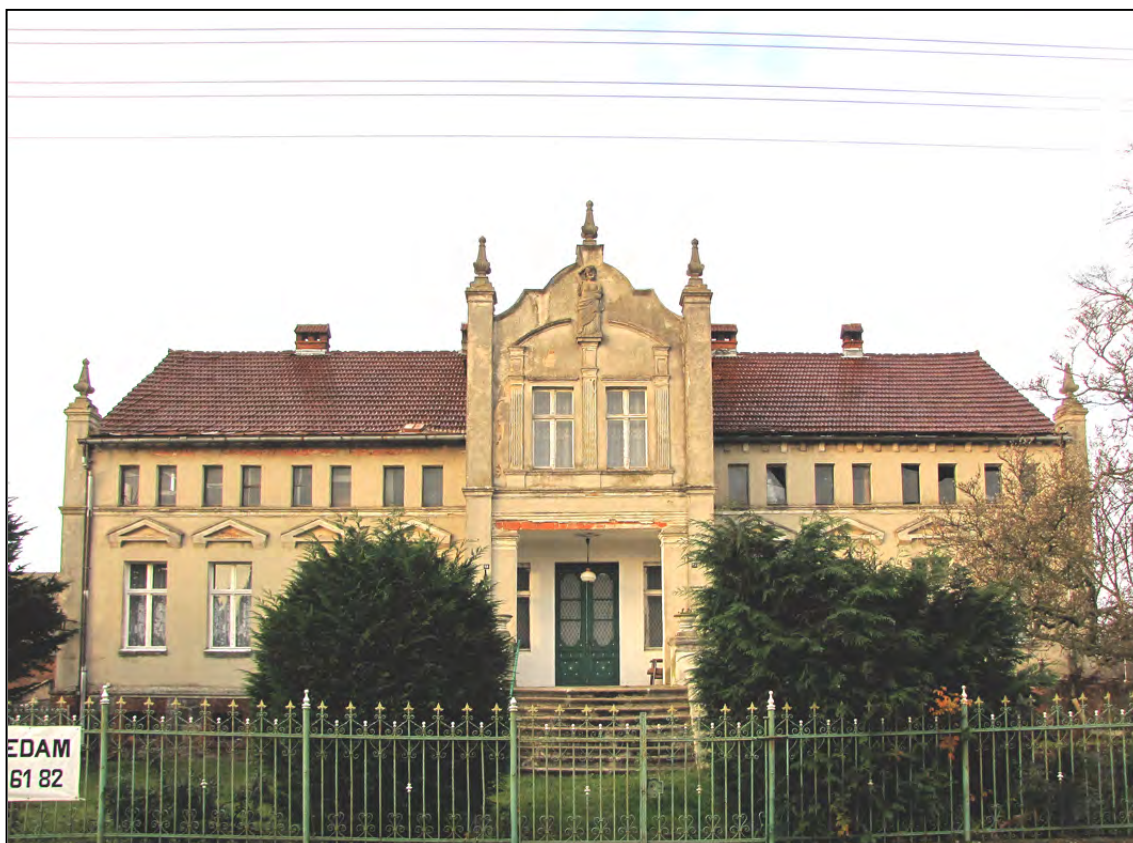
Swobnica 58/59. Budynek mieszkalny.
