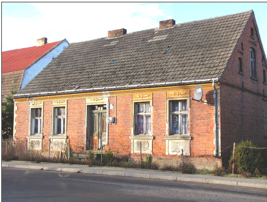
Lubanowo 42. Budynek mieszkalny (chałupa).
