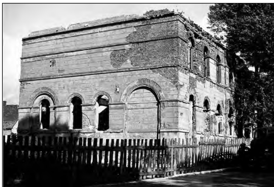
Banie. Ruiny Ratusza (elewacja wschodnia). Stan ok. roku 1969
