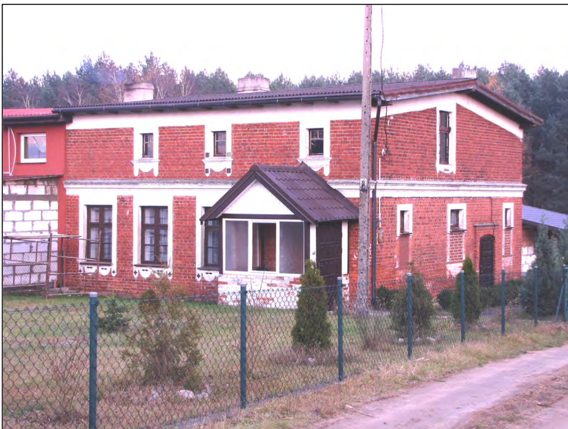
Swobnica 134/135. Budynek mieszkalny.
