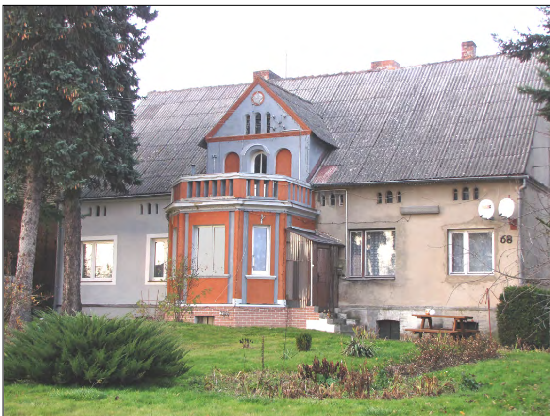
Swobnica 68. Budynek mieszkalny.
