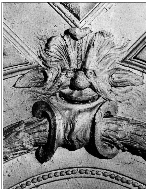
Zamek w Swobnicy. Sala Rycerska (Książęca). Barokowy maszkaron z dekoracji sztukatorskiej stropu. Stan ok. 2000 r.
