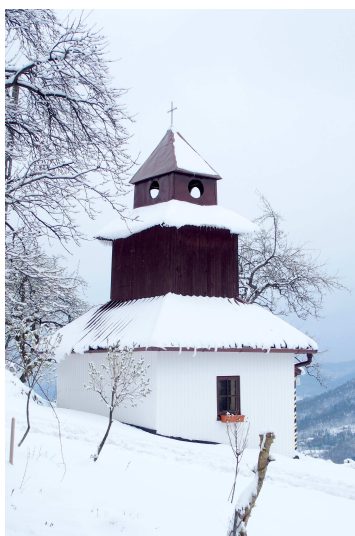
Zdjęcie nr 35. Kaplica - dzwonnica Brzezinka, os. Złota Górka
