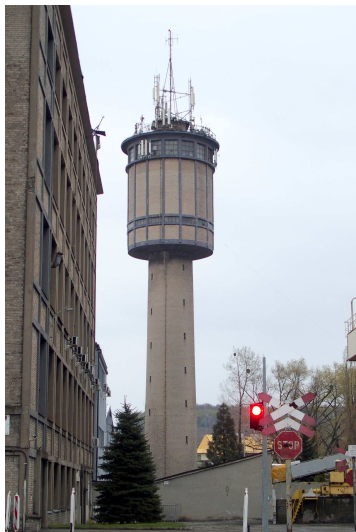
Zdjęcie nr 41. Wieża ciśnień, ul. Krakowska 83, Andrychów
