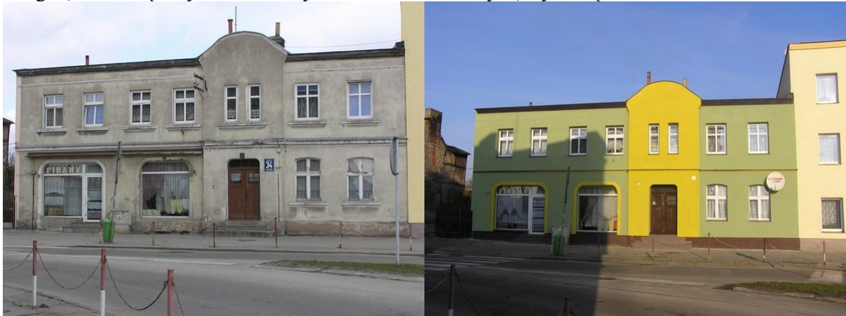
Kamienica przy ul. Chojnickiej 34 przed i po pracach remontowych (fot. PUP)
