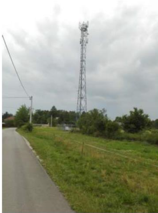
Stacja bazowa telefonii komórkowej w m. Krzaki.
