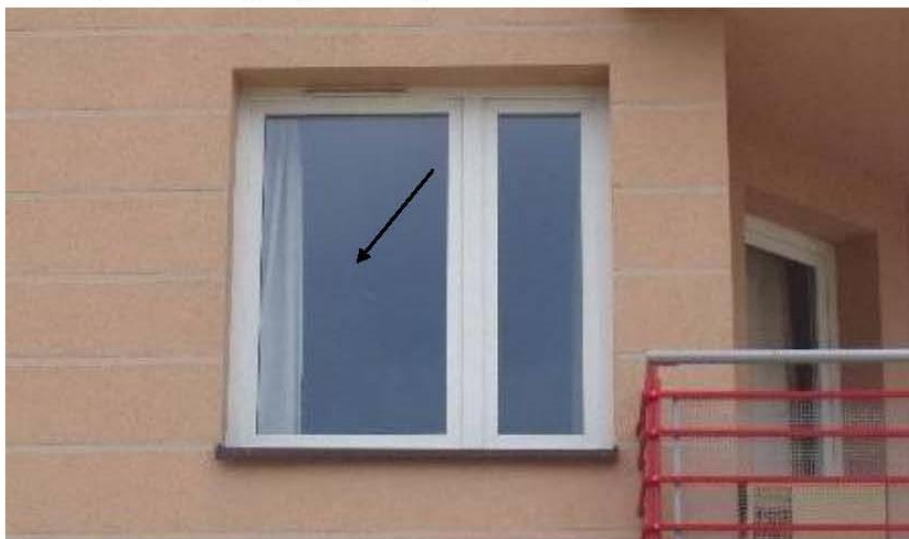
Rysunek 3-35 Okno dźwiękoszczelne z nawiewnikiem
