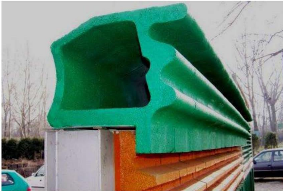
Rysunek 3-26. Dyfraktor zamontowany na krawędzi górnej ekranu akustycznego Źródło: techbud.com.pl
