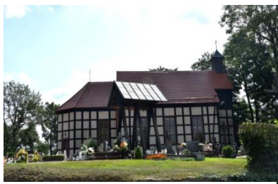
Fot. 1. Dąbrówka. Kościół parafialny pw. św. Michała Archanioła (fot. autor). Fot. 3. Duża Cerkwica. Kościół filialny pw. św. Wojciecha (fot. autor).
