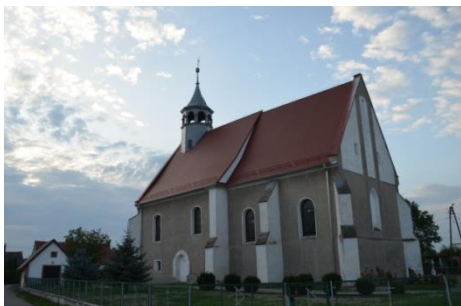
Fot. 31. Osiek Grodkowski. Kościół filialny pw. Wniebowzięcia NMP.
