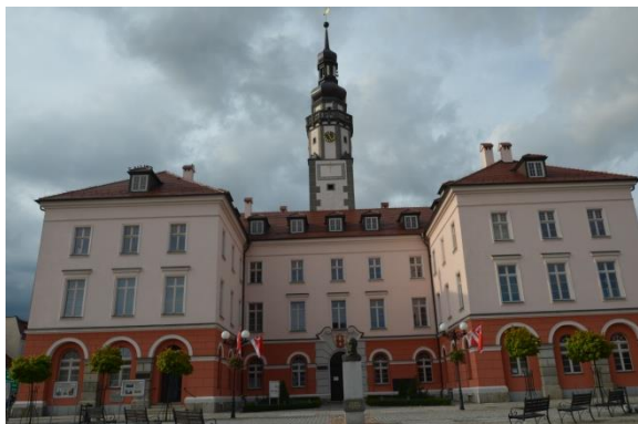
Fot. 4. Grodków, Budynek ratusza, ul. Rynek 1.
