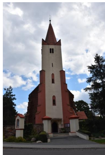
Fot. 29. Lipowa. Kościół pw. św. Marcina.
