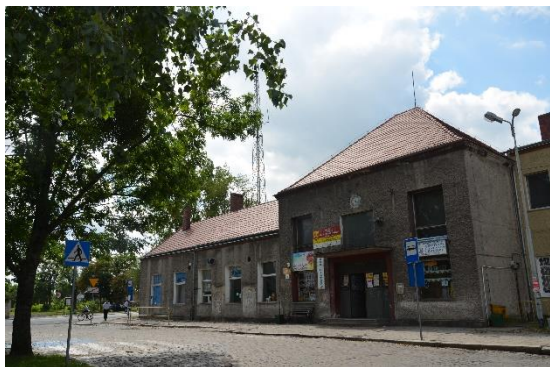
Fot. 9. Grodków. Budynek dworca PKP, ul. Warszawska.
