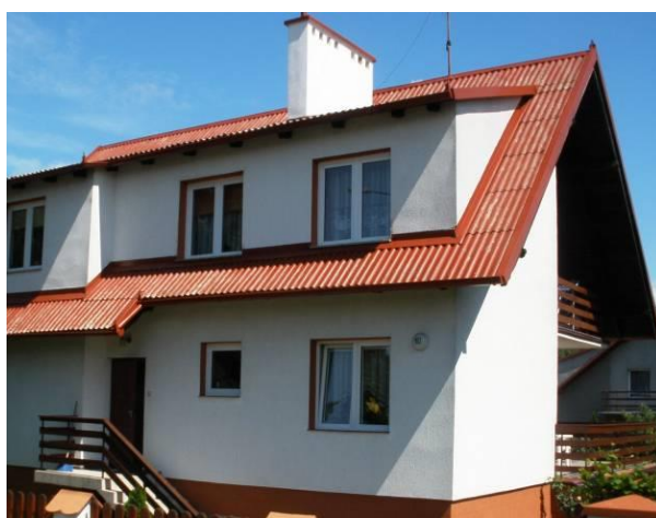
Rys. 5. Przykład zabezpieczenia wykonanego powłoką malarską.
