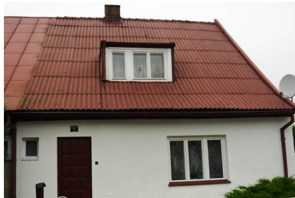
Rys. 6. Pokrycie dachowe ocenione w III stopniu pilności.
