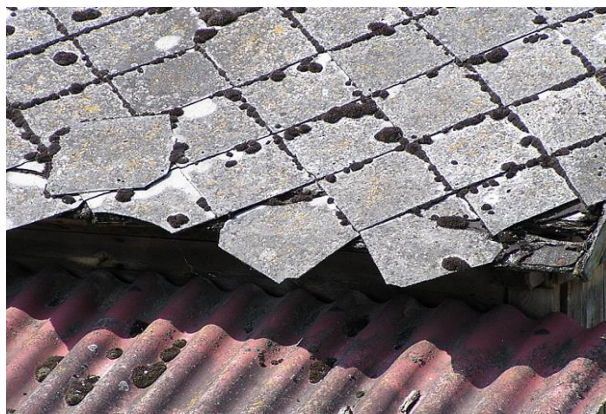
Rys. 8. Pokrycie dachowe ocenione w I stopniu pilności.
