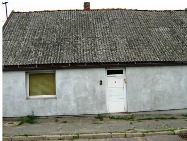
Rys. 7. Pokrycie dachowe ocenione w II stopniu pilności.
