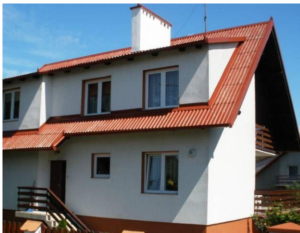
Rys. 5. Przykład zabezpieczenia wykonanego powłoką malarską
