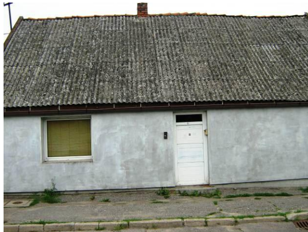
Rys. 7. Pokrycie dachowe ocenione w II stopniu pilności
