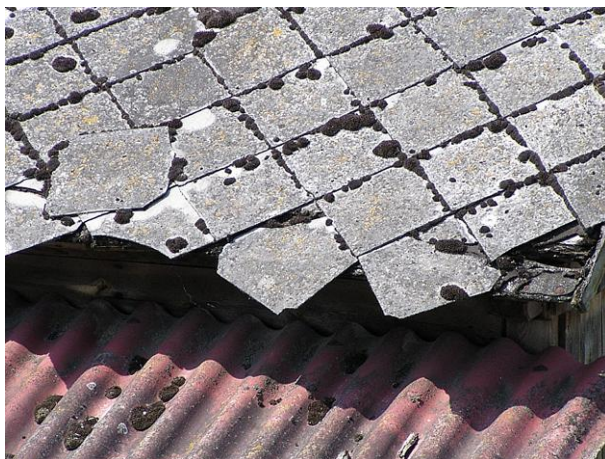
Rys. 8. Pokrycie dachowe ocenione w I stopniu pilności
