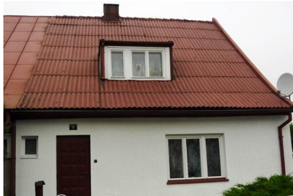
Rys. 6. Pokrycie dachowe ocenione w III stopniu pilności
