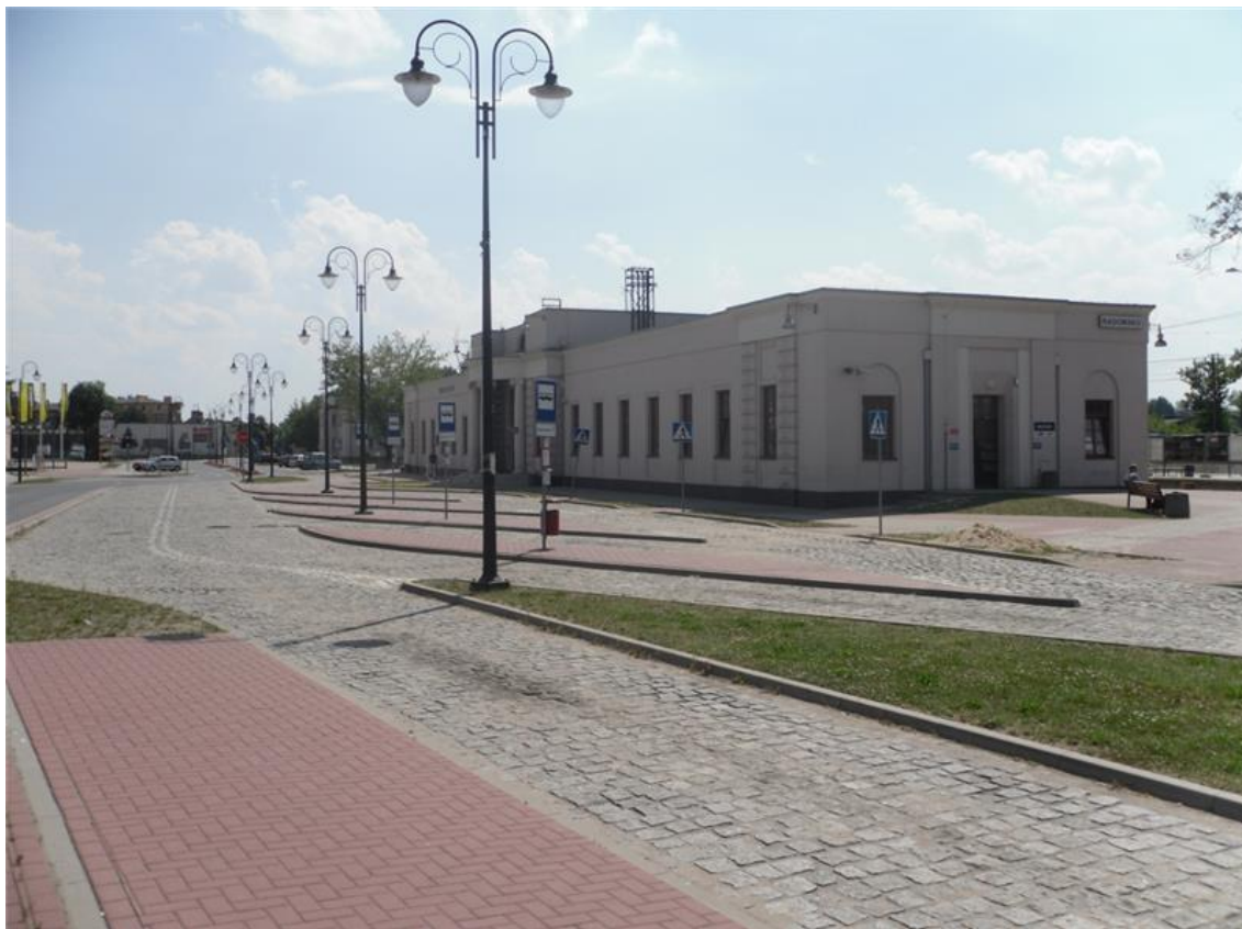
Zdjęcie 1. Widok ogólny na węzeł przesiadkowy w Radomsku (fot. Refunda sp. z o.o.)
