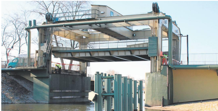
Rycina 19. Most nad kanałem portowym w Nowej Soli
