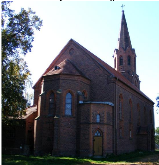
Zdjęcie nr 7. Kościół filialny Wniebowstąpienia Pana Jezusa, Jaksonowice
