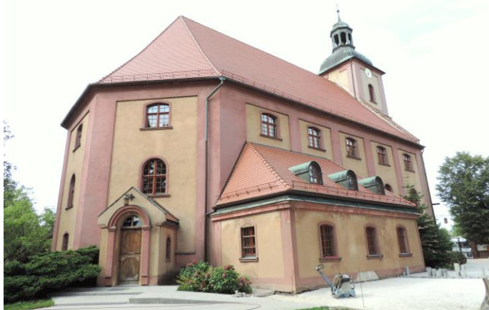
Zdjęcie nr 9. Kościół parafialny MB Różańcowej, Kielczów, ul. Wrocławska
