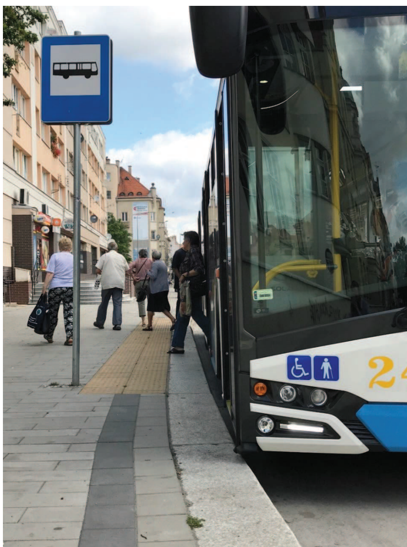
Rys. 9.8 Wyrównanie wysokości krawędzi peronowej z pierwszymi drzwiami autobusu, Legnica ul. Jaworzyńska
