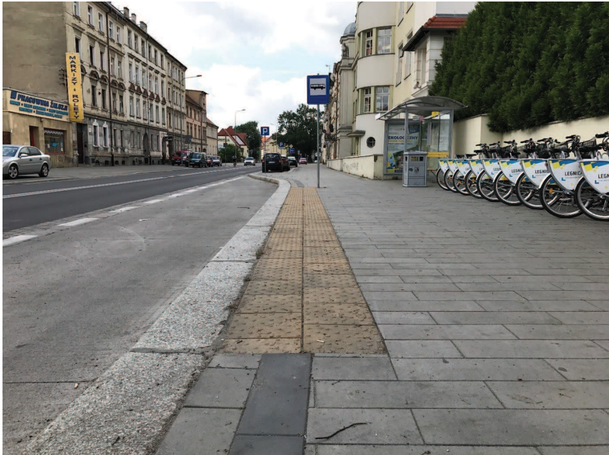
Rys. 9.9 Zalecane ukształtowanie podniesionej krawędzi peronowej na przykładzie ul. Jaworzyńskiej w Legnicy.
