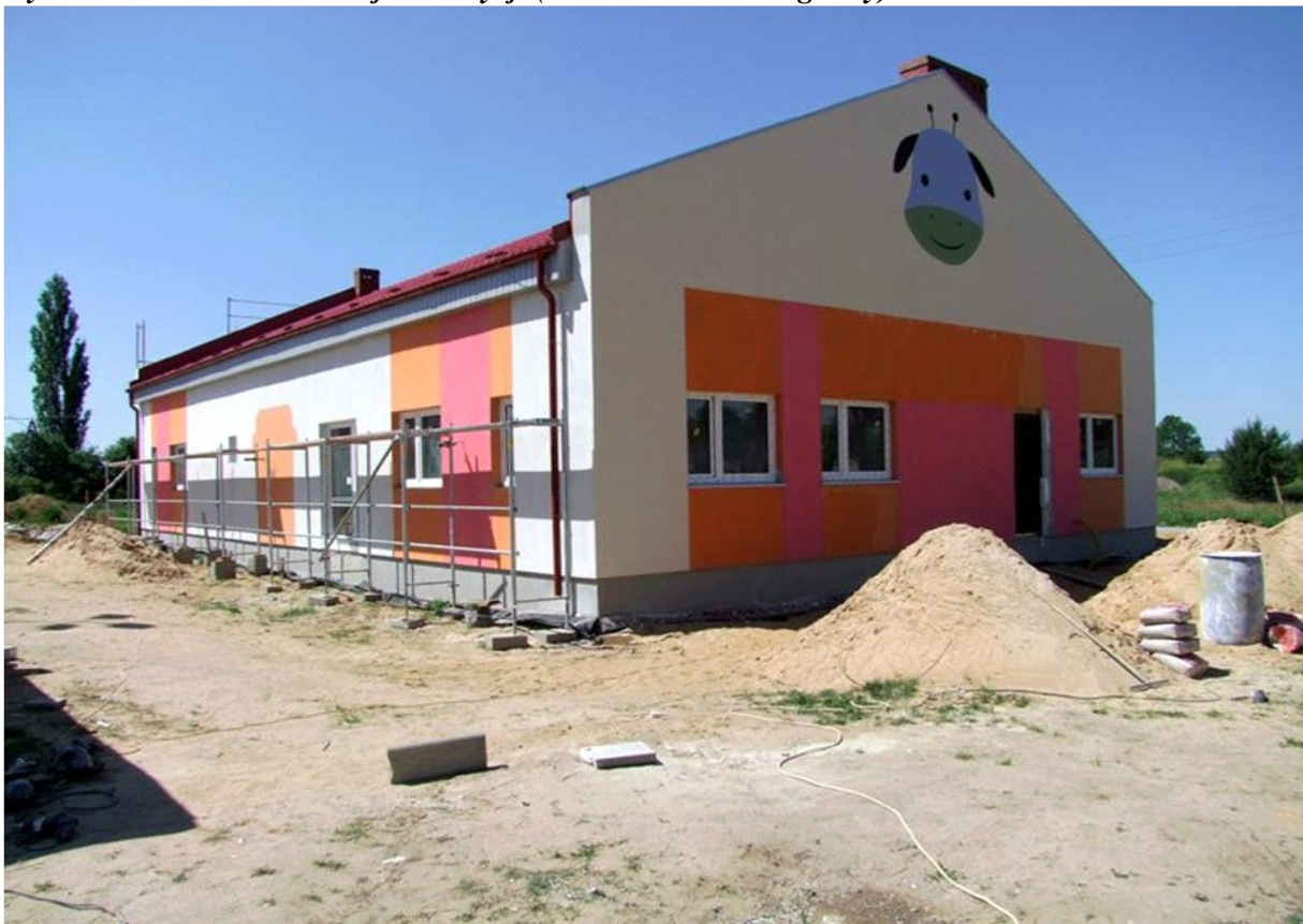
Zdj. inwestycja- budowa dwuoddziałowego przedszkola w Wąsoszu przy ulicy Korczaka - zdjęcie wykonane w trakcie realizacji inwestycji (materiał z zasobów gminy)
