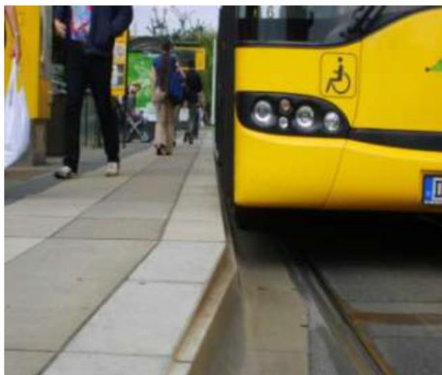
Rys. 8.6.1. Zalecane ukształtowanie krawędzi peronowej.
