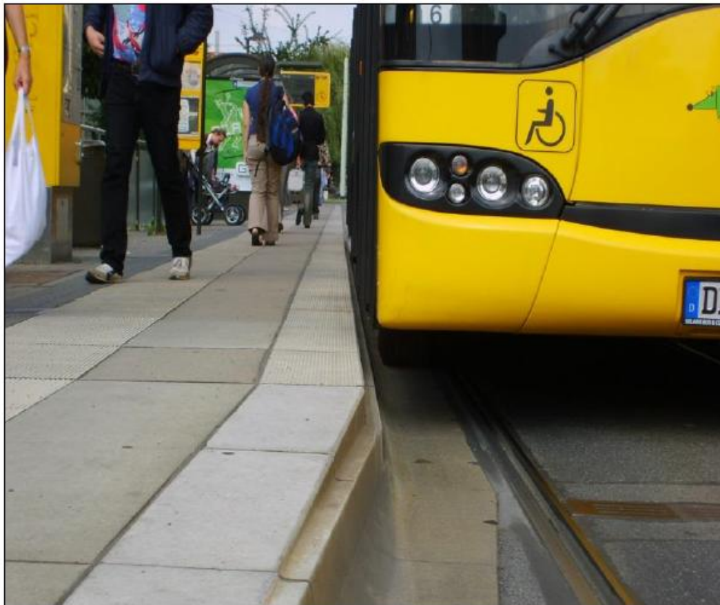
Rys. 30 Zalecane ukształtowanie krawędzi peronowej (Drezno – Niemcy) 58
