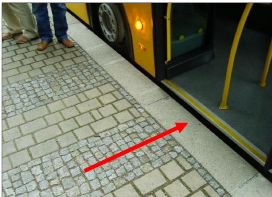
Rys. 32 Strefa wejściowa – inny rodzaj nawierzchni naprzeciwko pierwszych drzwi autobusu (Drezno) 60
