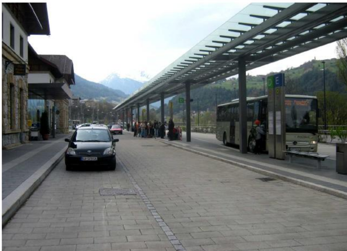
Rys.VIII.10. Stacja Landeck – Zams. (źródło: zbiory własne)
