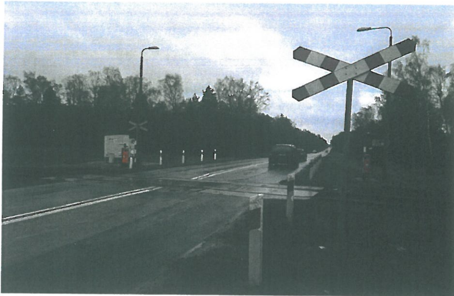
Zdjęcie przejazdu kat. A w km 37,119 szlaku Śniadowo – Łapy linii kolejowej nr 36 – widok od strony nadjeżdżającego samochodu przed znakiem G-3 (Krzyż św. Andrzeja).
