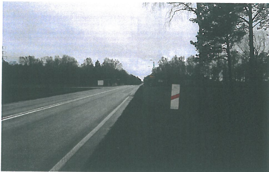
Zdjęcie w kierunku przejazdu kat. A w km 37,119 szlaku Śniadowo – Łapy linii kolejowej nr 36 – widok od strony nadjeżdżającego samochodu przed znakiem G1-c.
