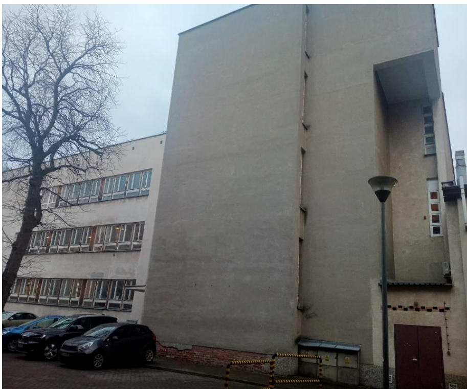
Zdjęcie nr 6 - Budynek nr 5 elewacja wschodnia.
