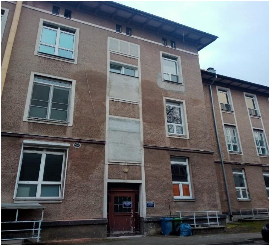
Zdjęcie nr 5 - Budynek nr 4 elewacja zachodnia.
