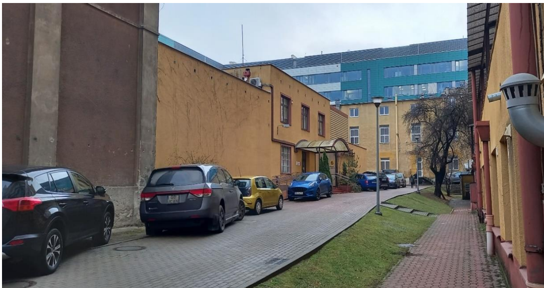
Zdjęcie nr 4 – Budynek nr 6 przeznaczony do rozbiórki.
